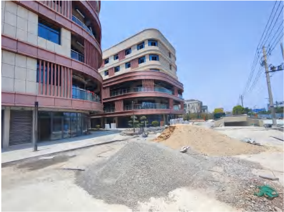
项目现场情况（2022.6）
