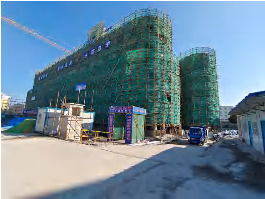
项目现场情况（2021.12）
