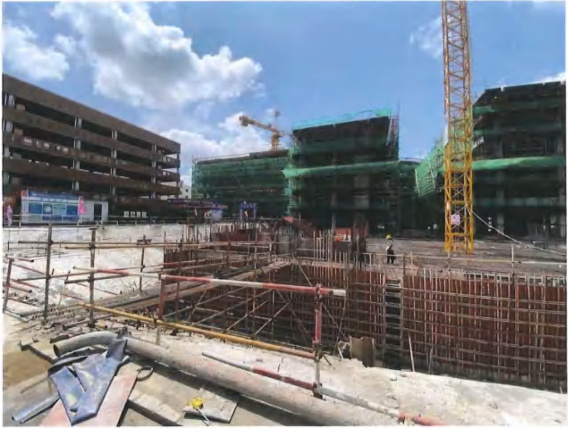
项目现场情况 (2021.9)
