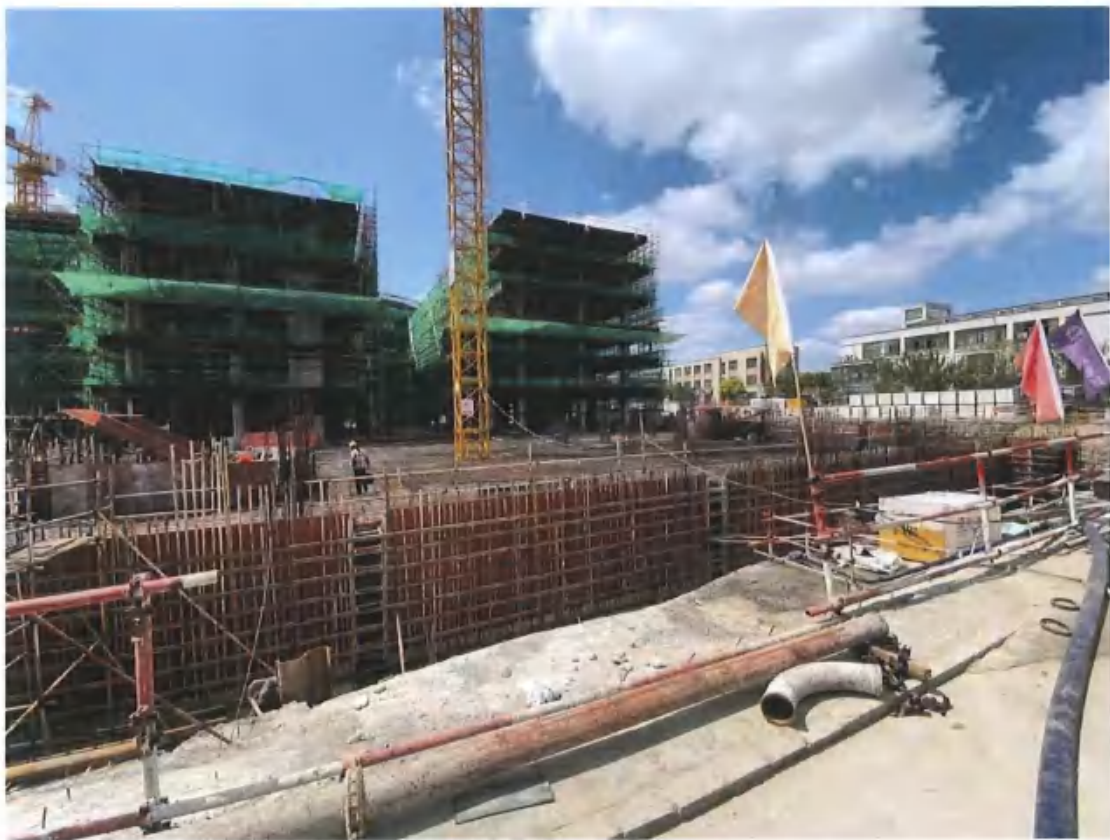
项目现场情况 (2021.9)
