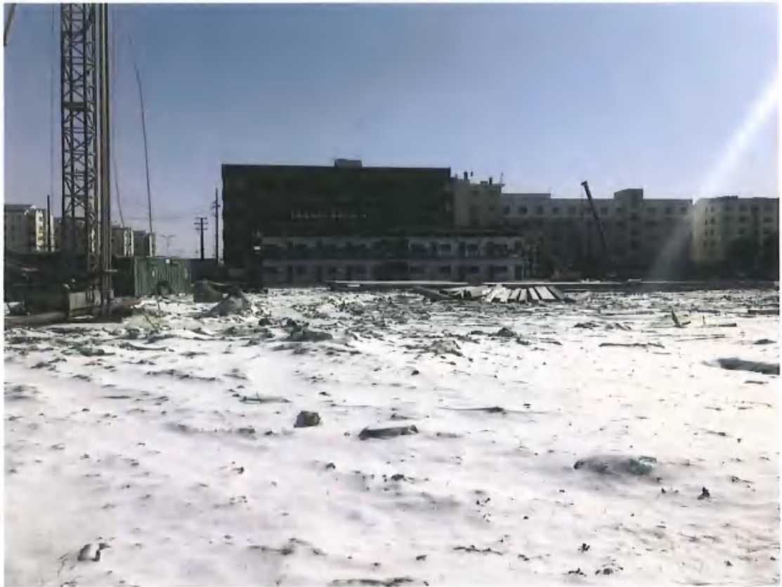
项目现场情况 (2020.12)
