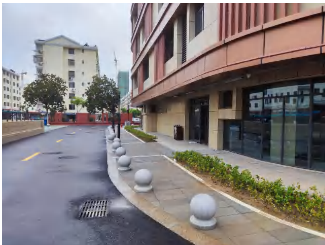
项目现场情况（2022.9）
