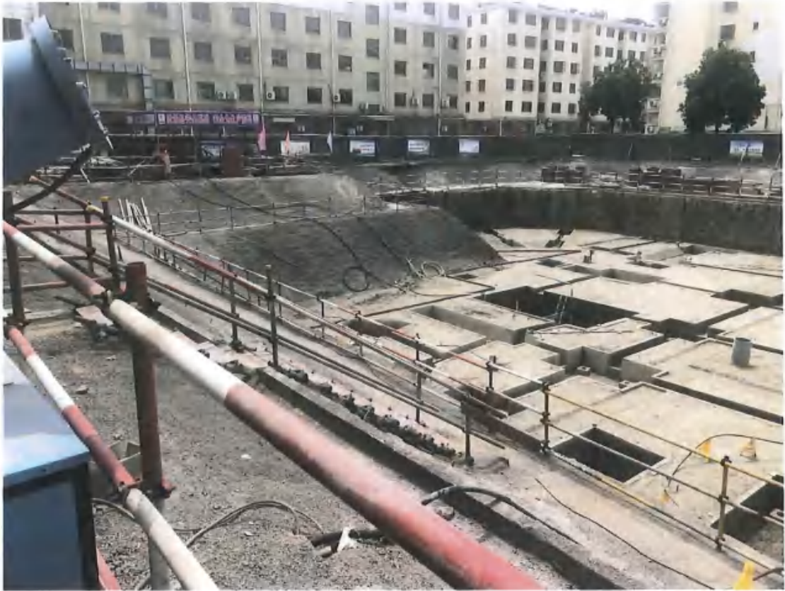
项目现场情况 (2021.5)
