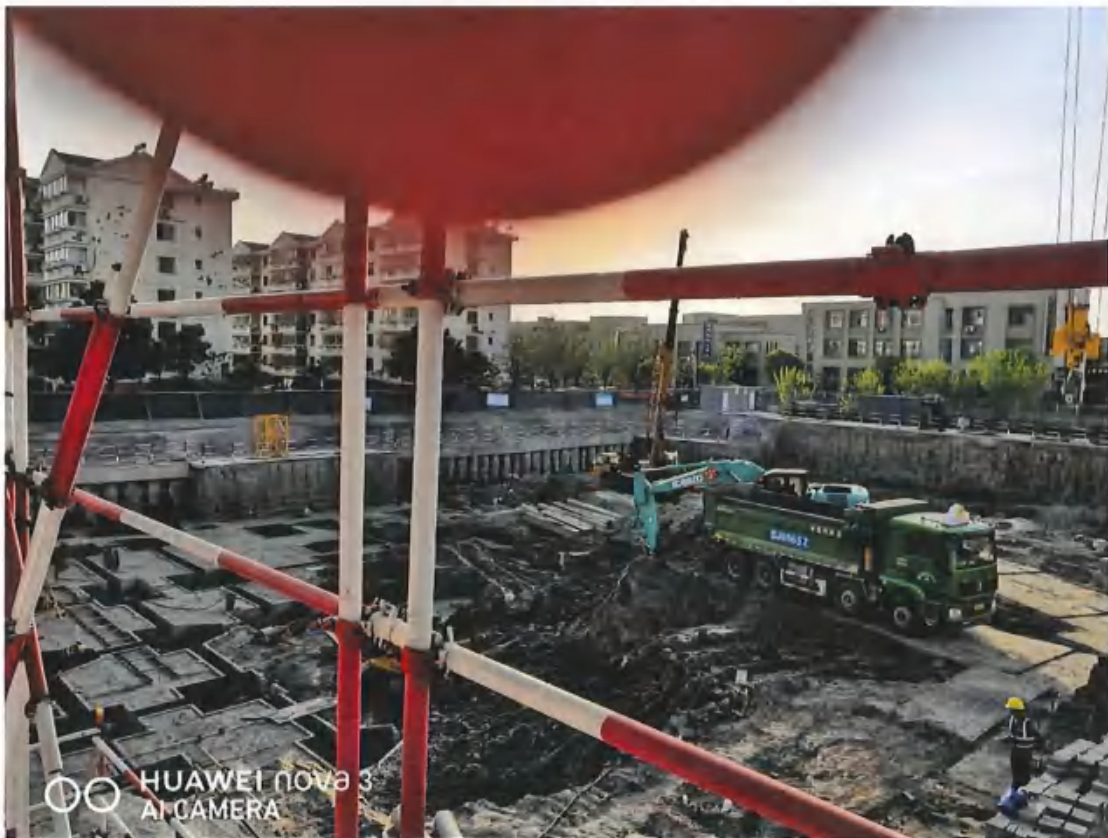
项目现场情况 (2021.3)
