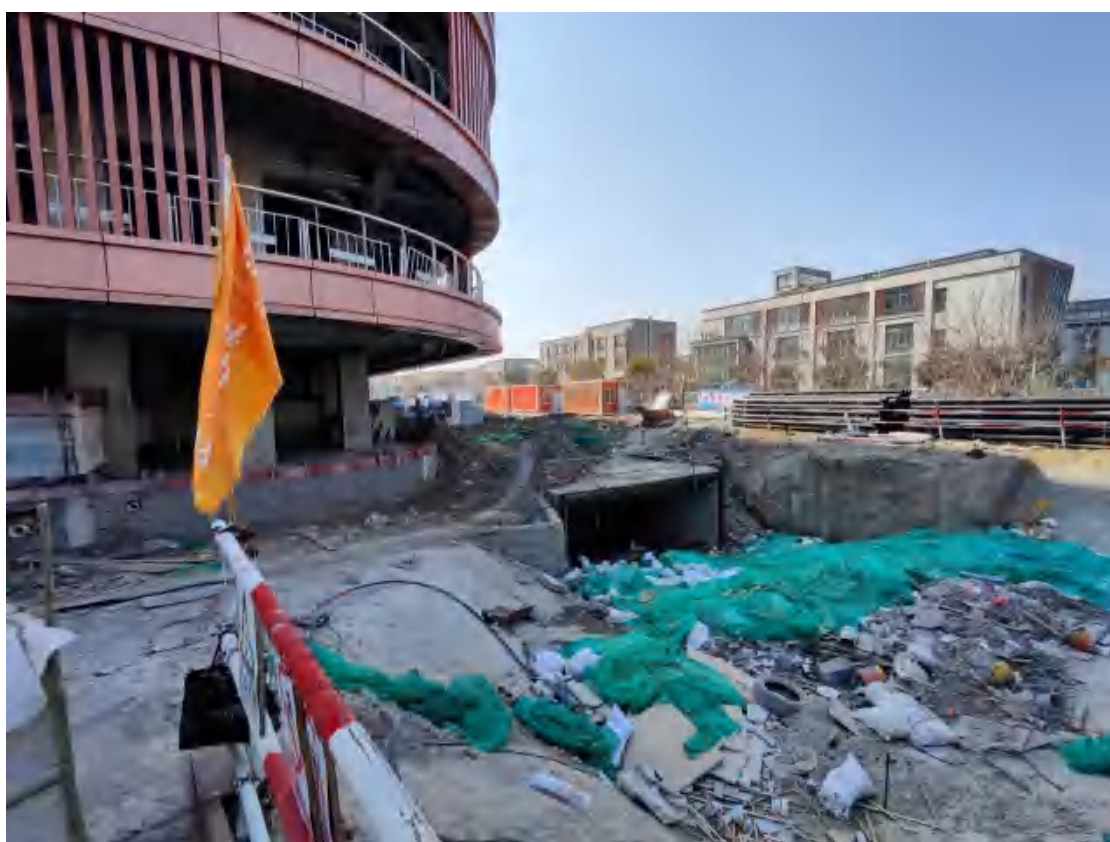
项目现场情况 (2022.2)
