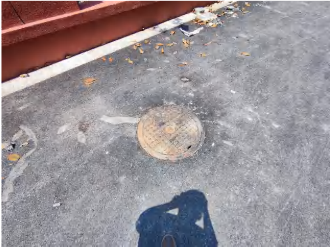
项目现场情况 (2022.6)
