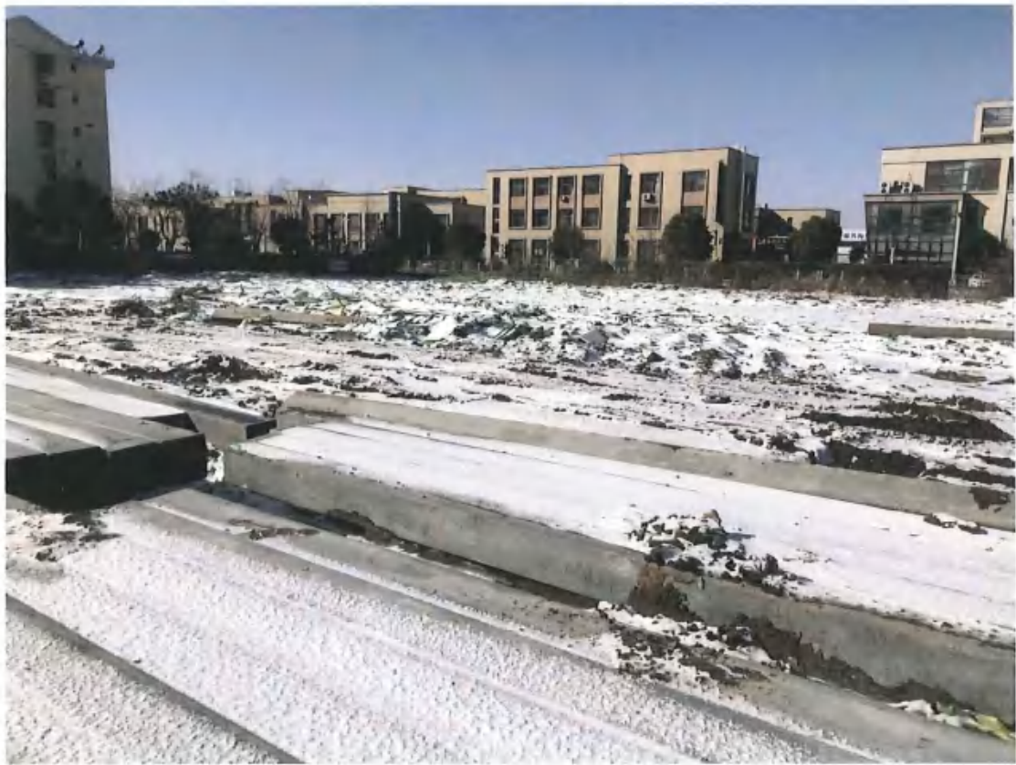
项目现场情况 (2020.12)
