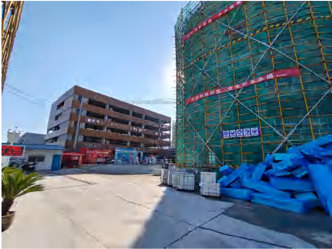
项目现场情况（2021.12）
