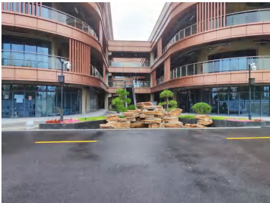
项目现场情况（2022.9）
