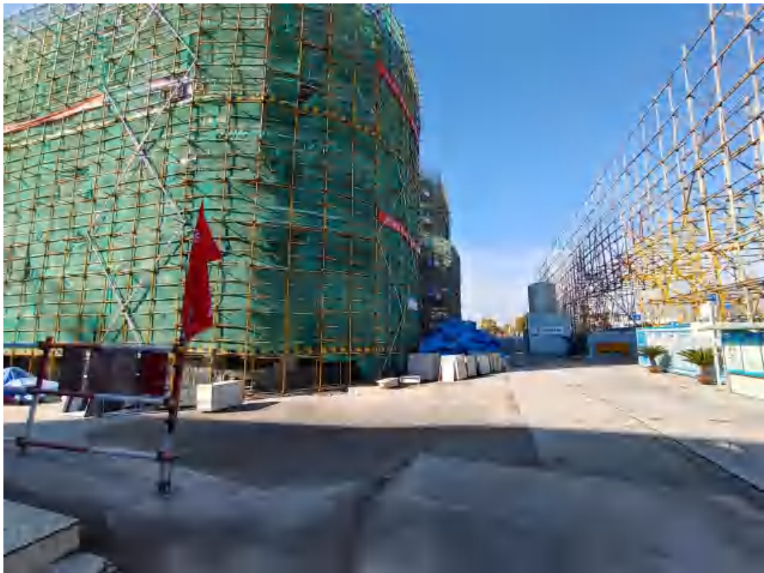
项目现场情况（2021.12）
