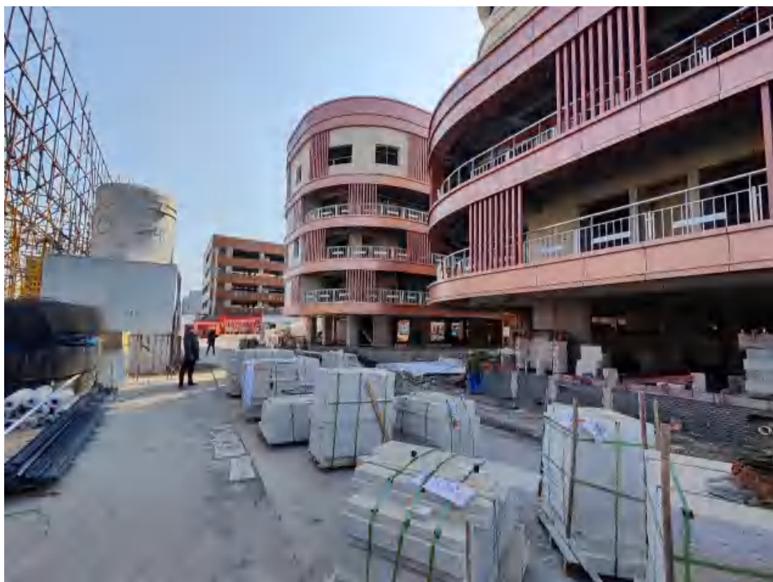
项目现场情况 (2022.2)
