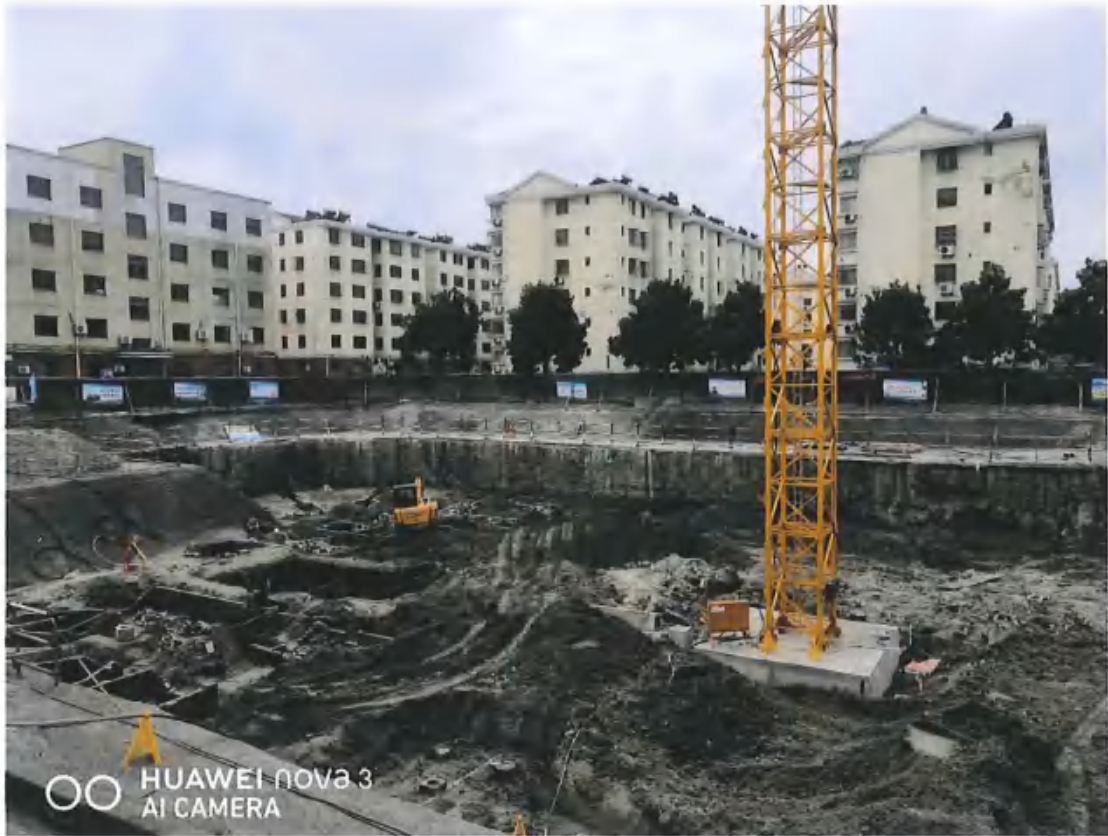
项目现场情况 (2021.2)
