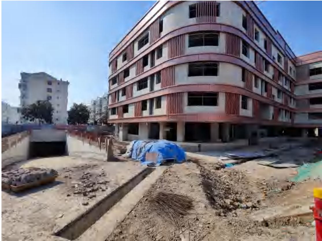
项目现场情况（2022.2）
