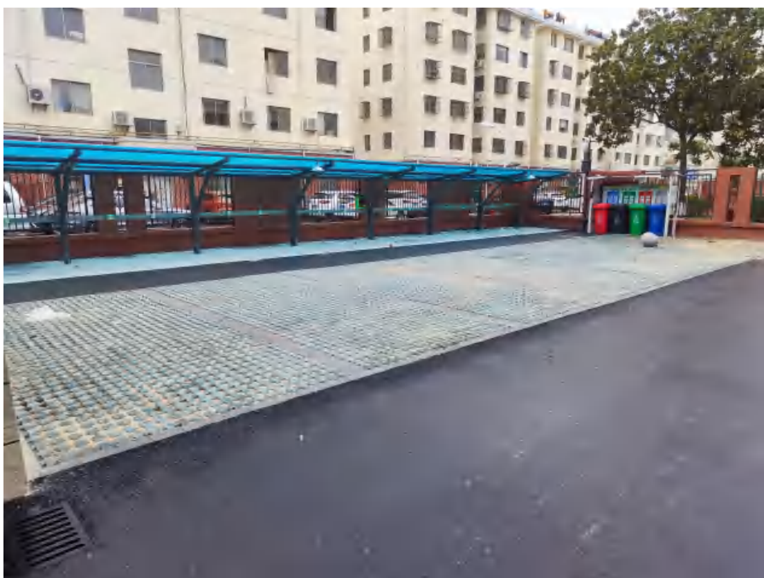
项目现场情况（2022.9）
