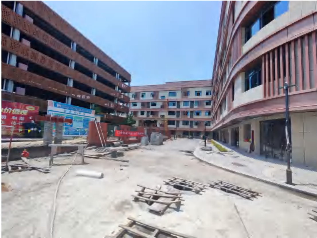
项目现场情况（2022.6）
