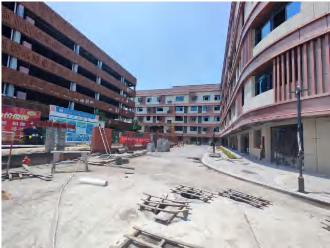
项目现场情况（2022.6）
