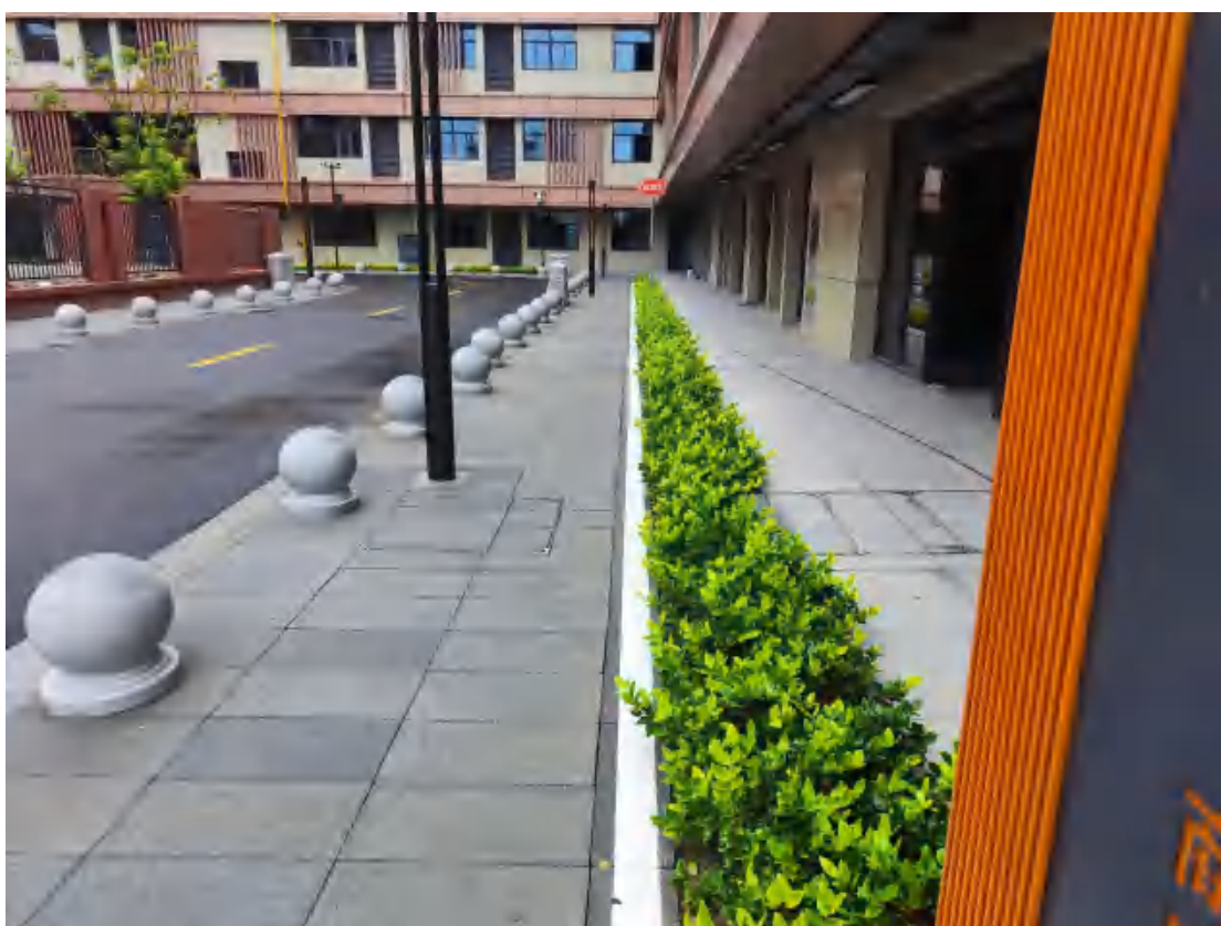
项目现场情况（2022.9）
