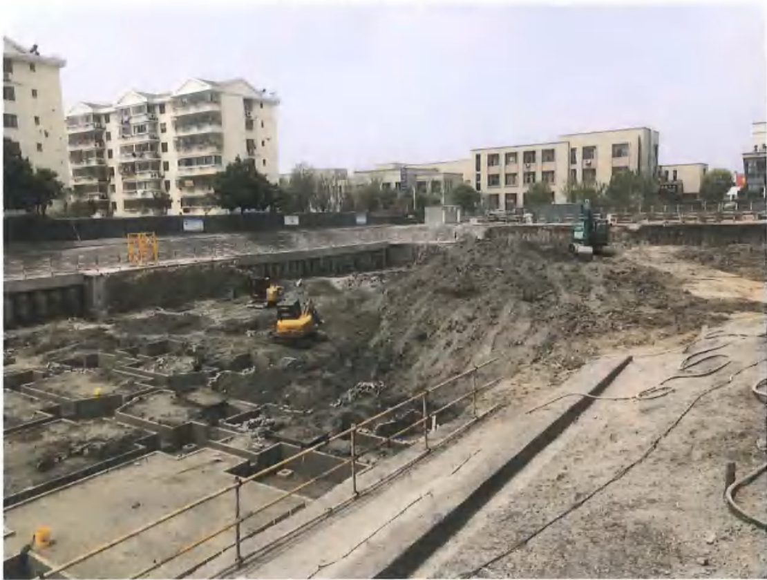
项目现场情况 (2021.5)
