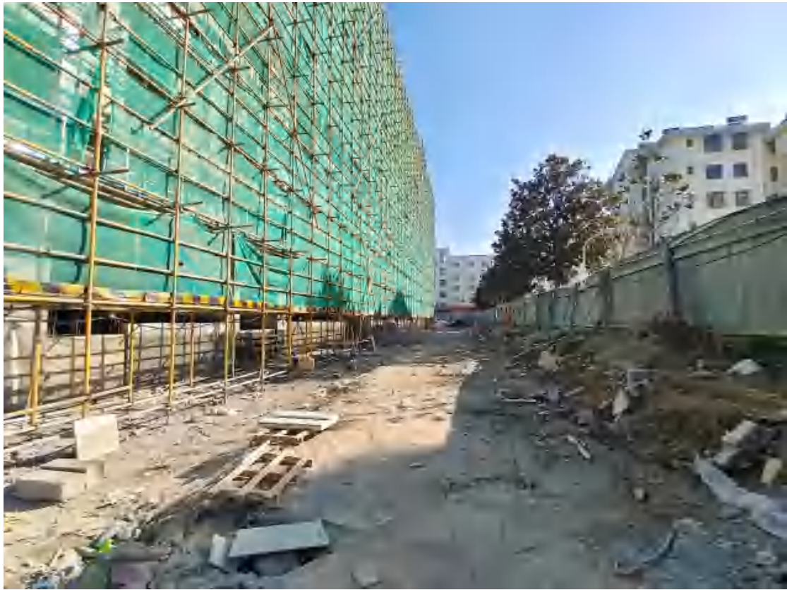
项目现场情况（2021.12）
