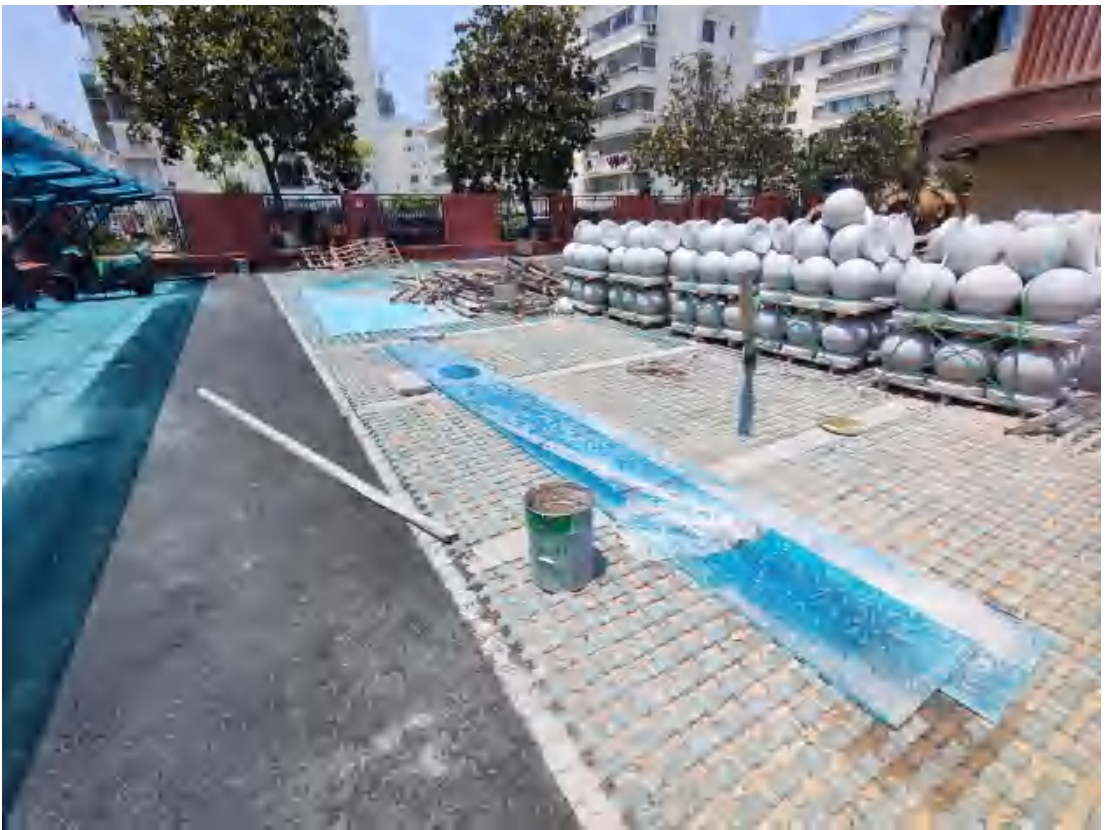
项目现场情况（2022.6）
