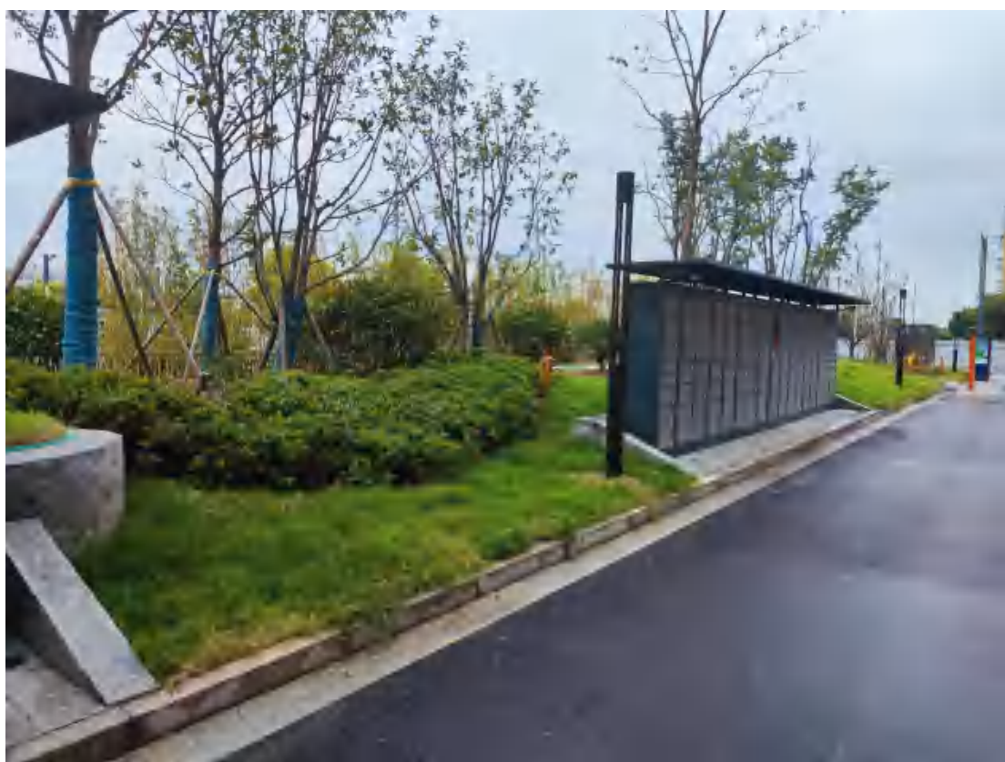
项目现场情况（2022.9）
