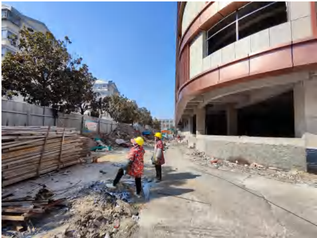
项目现场情况（2022.2）
