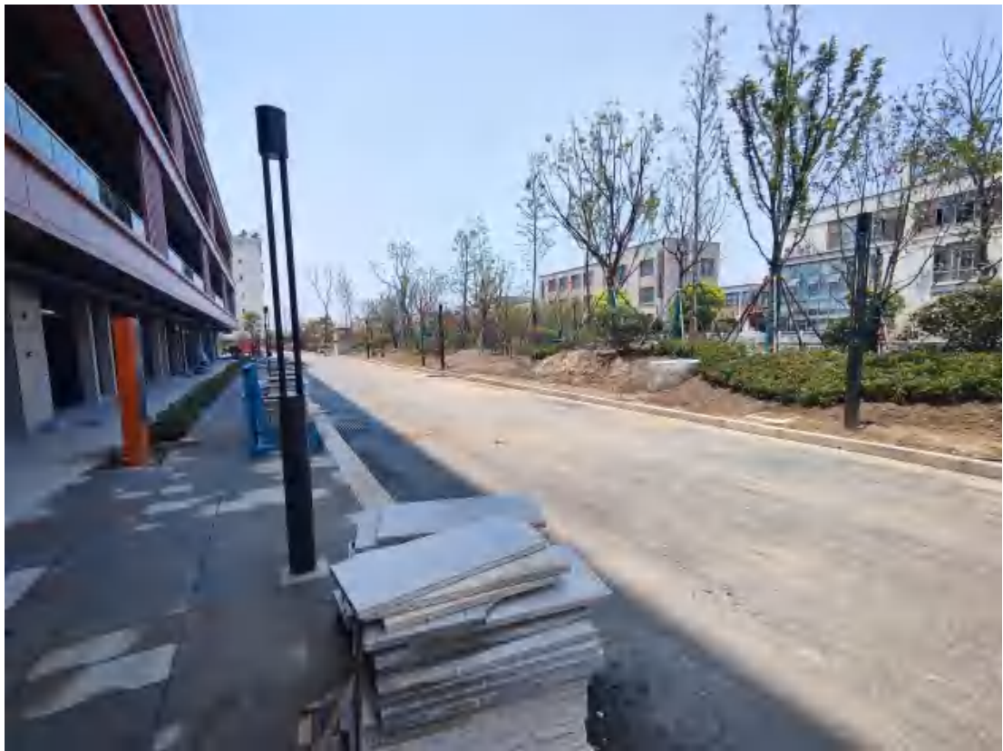
项目现场情况 (2022.6)
