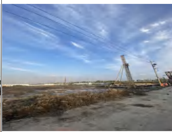
照片 8 D 地块桩基施工（2021.9）
