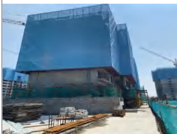
照片 5 B 地块建筑区监测点（2021.06.15）
