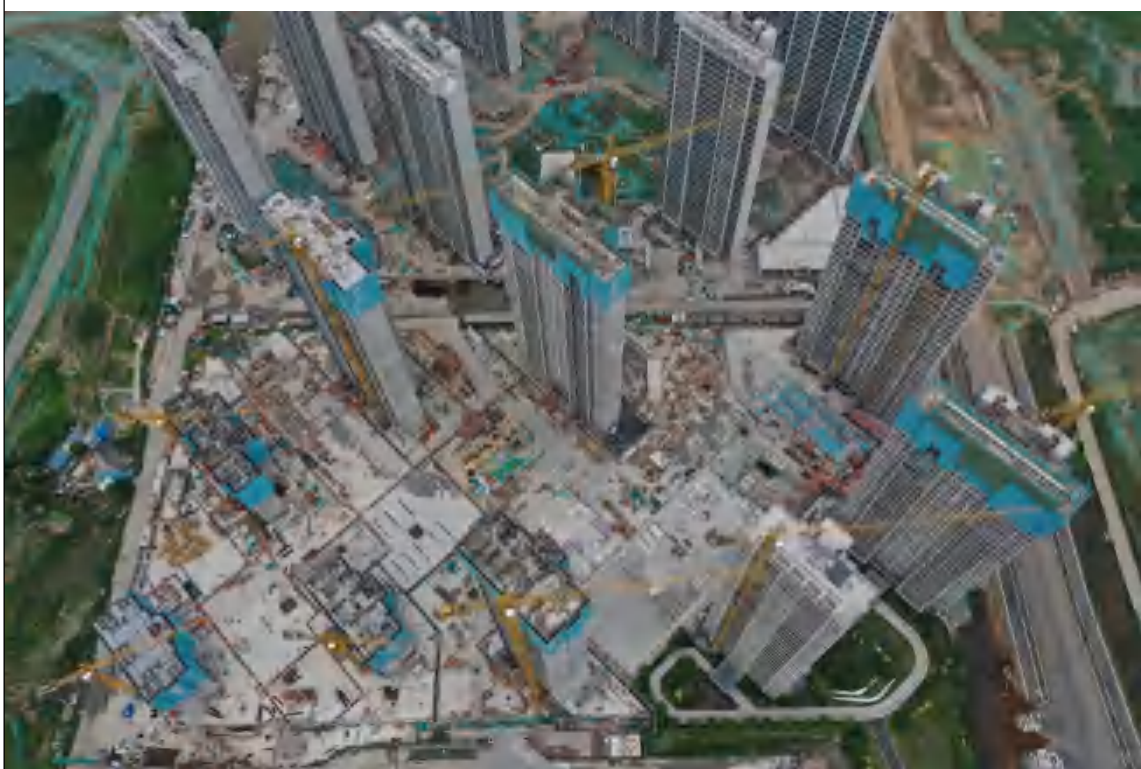
照片 10 拍摄时间：2022.6.27 监测分区：B 地块 监测位置：/ 现场情况：主体工程施工 建议：对裸露地表及时进行苫盖，注意巡查排水系统
