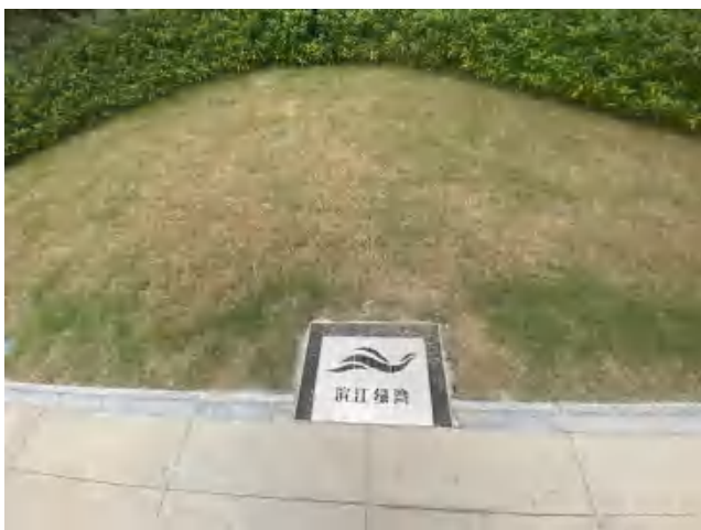
照片 5: 排水管网 (2023.7)
