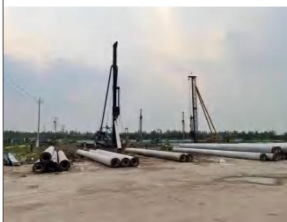
照片 9 D 地块桩基施工（2021.9）
