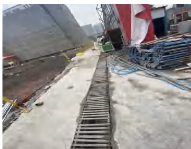
照片 5 拍摄时间：2022.12.24 监测分区：F 地块道路广场区 监测位置：/ 现场情况：沿基坑布设临时排水沟，砖砌结构，断面尺寸 0.30*0.40m，长度 660m 建议：注意巡查排水系统
