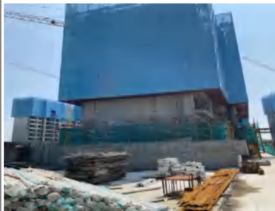
照片 6 B 地块建筑区监测点（2021.06.15）
