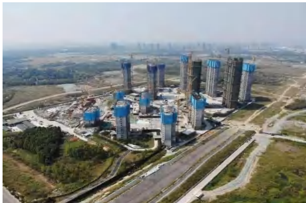
照片 10 A、B 地块全景图（2021.9）
