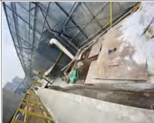
照片 6 拍摄时间：2022.12.24 监测分区：F 地块道路广场区 监测位置：监测点（6#） 现场情况：F 地块出水口，砖砌结构，断面尺寸 3*4*1.5m 建议：注意巡查排水系统
