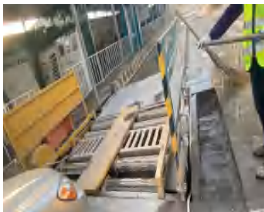
图 3.5-7 洗车平台及配套沉淀池 (2021.6) 图 3.5-8 临时排水沟 (2021.6)
