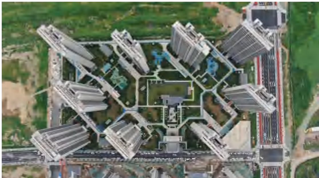
图 1.1-1 项目无人机影像图(已完工,2023 年 7 月 17 日)
