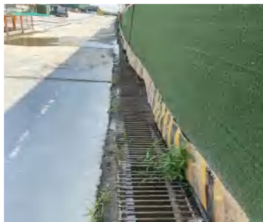
图 3.5-7 洗车平台及配套沉淀池 (2021.6) 图 3.5-8 临时排水沟 (2021.6)
