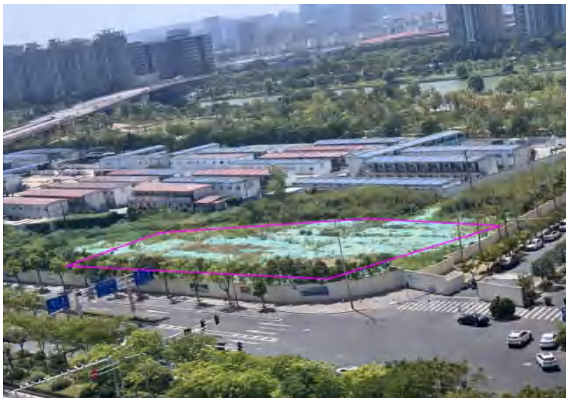
图 3-7 施工生产生活区撒播草籽
