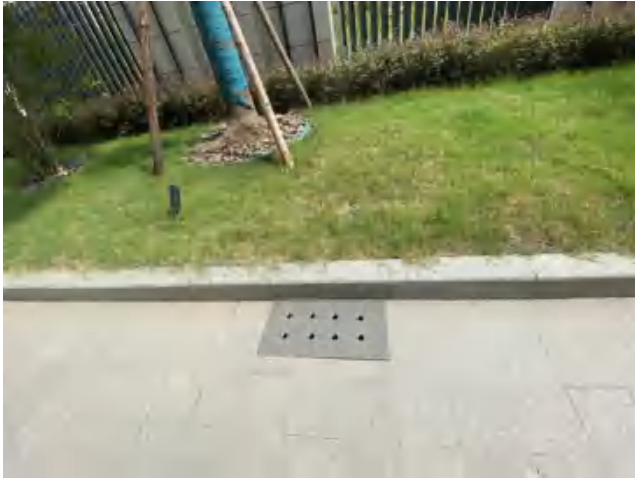
照片 1: 排水管网 (2023.3)
