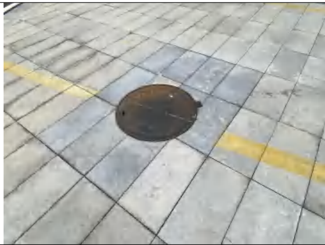
照片 9: 透水铺装 (2023.6)
