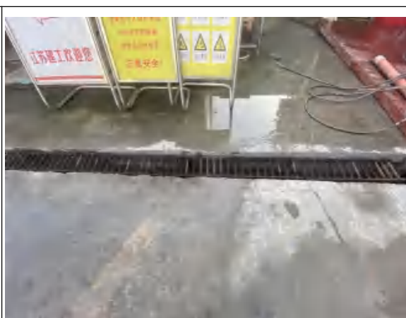
照片 2 临时排水沟（2021.9）
