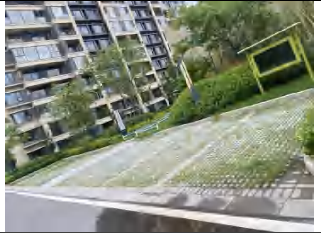
照片 8: 透水铺装 (2023.6)
