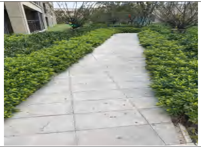
照片 10: 透水铺装 (2023.6)
