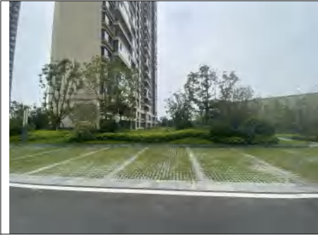
照片 7: 透水铺装 (2023.6)
