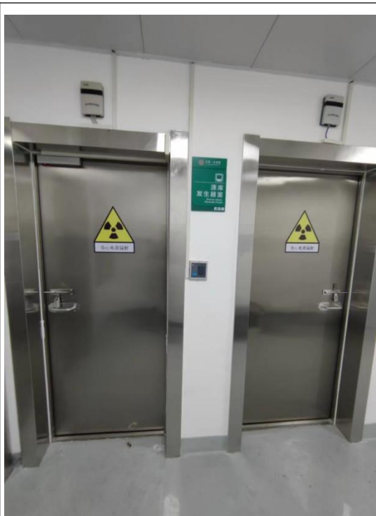
源库门禁系统、电离辐射警告标志、报警装置
