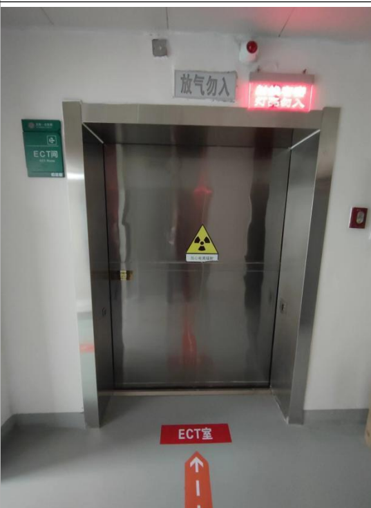
源库门禁系统、电离辐射警告标志、报警装置
