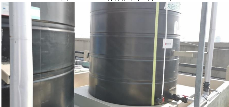
图 4.1-2 液碱储罐现场照片
