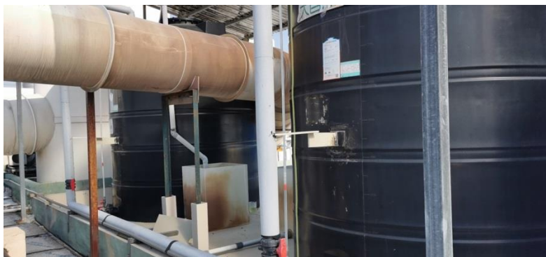
图 4.1-1 盐酸储罐现场照片
