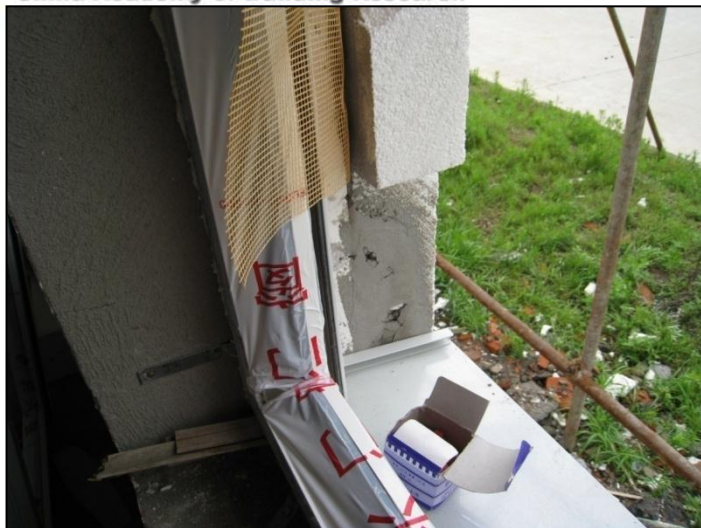
安徽某改造项目的外墙保温施工
