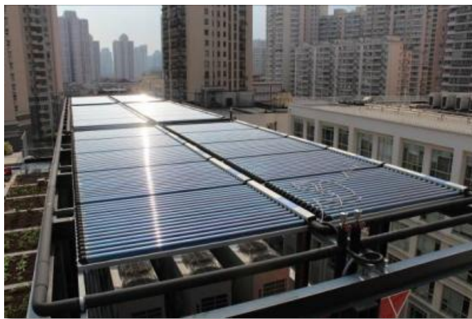
上海某改造项目的太阳能热水集热器
