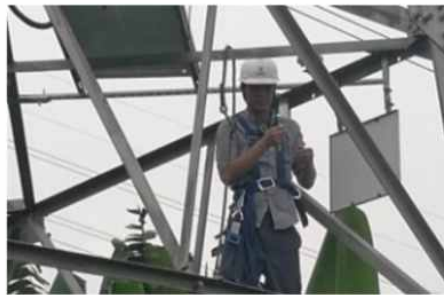
电力巡检施工
