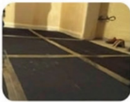
铺设石墨EPS保温隔声板，板缝对齐 缝宽应小于1MM
