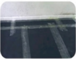
在保温隔声板与竖向隔声片接缝处粘贴防水胶带
