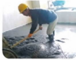
浇筑C20细石混凝土 厚度为40MM
