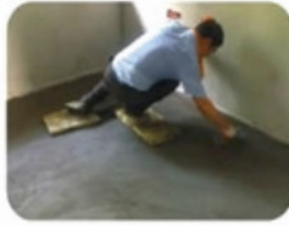
混凝土夯实、找平、拉毛
