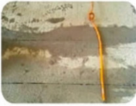
混凝土凝固后切割伸缩缝
