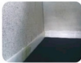
在室内四周铺设8CM高竖向隔声片 接缝处应小于1MM
