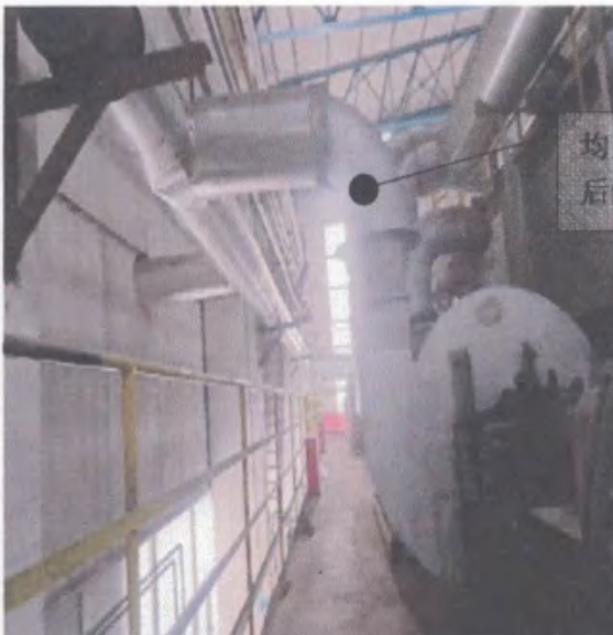
熔铸车间均质炉废气排放口照片：
