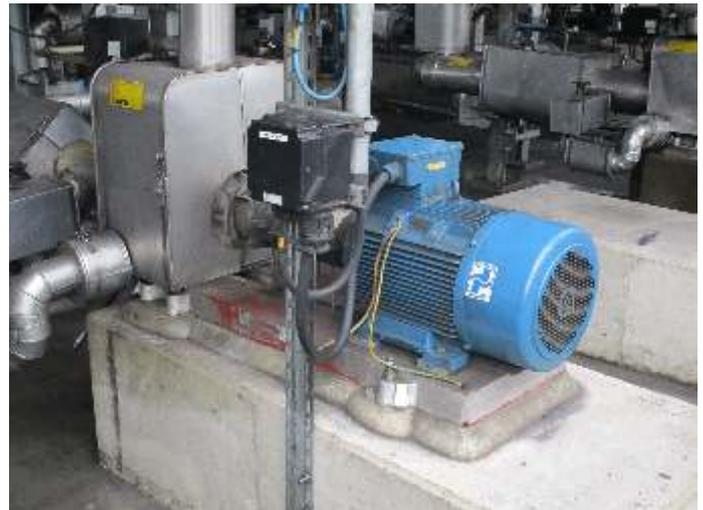
**Kreiselpumpe im Kolonnenumlauf (Medium: Basisöl)**
