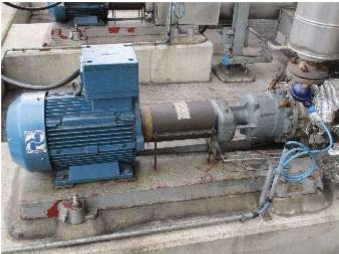
**Magnetgekuppelte Kreislumppe der Baureihe CNH-ML im Kolonnenumlauf (Medium: Naphtha)**
