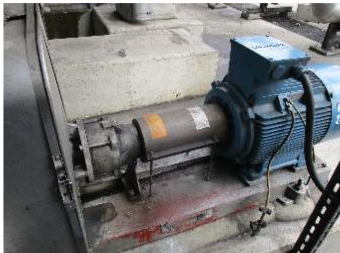
**Kreislumppe der Baureihe CTWH im Kolonnenumlauf (Medium: Basisöl)**
