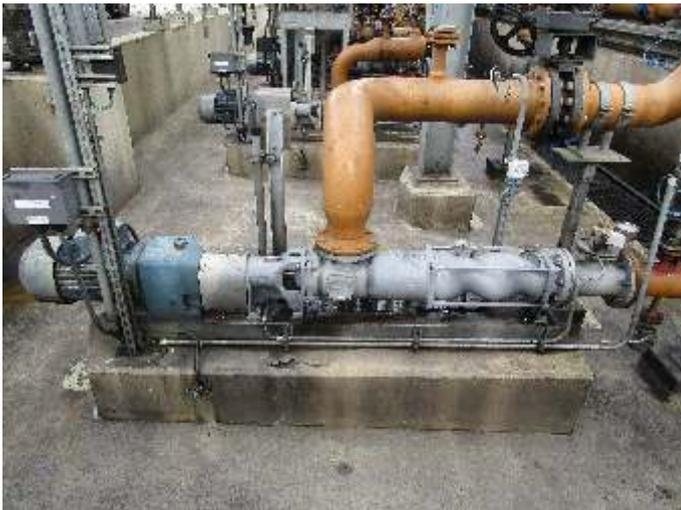
**Exzenterschneckenpumpe in der Haupt-Altöhlentladung**
