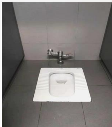
卫生器具安装端正、美观，与瓷砖居中对称
