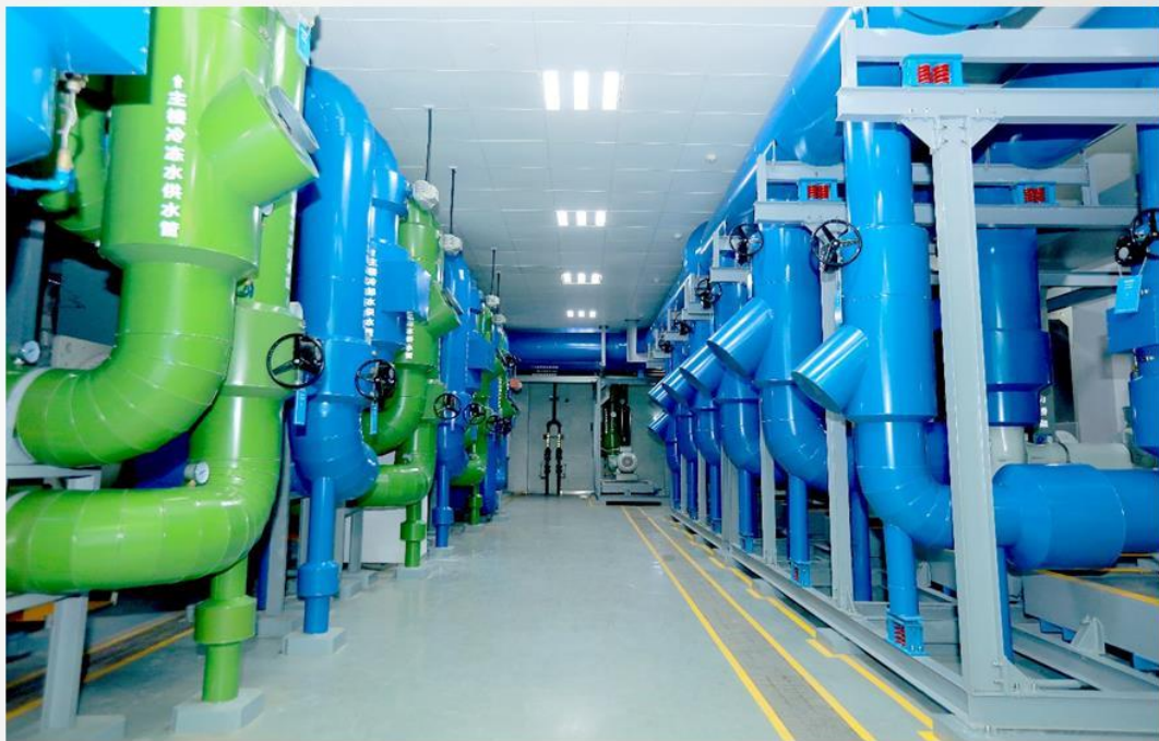
设备、管道及阀门装配式施工，排列整齐，成排成行
