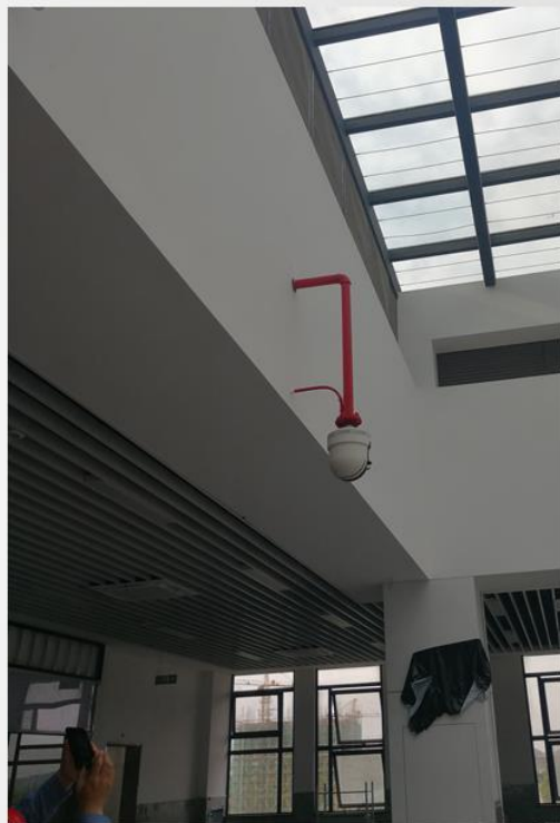
消防水炮连接短管无防晃支架
