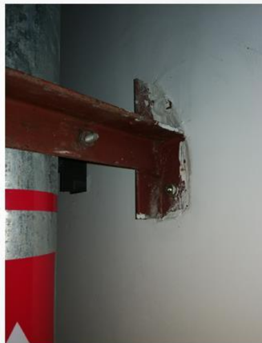
支架根部处理粗糙、面漆漏刷
