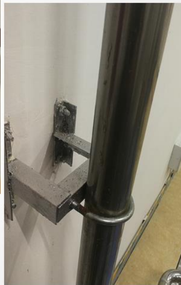
不锈钢管碳素钢支架无隔离措施
