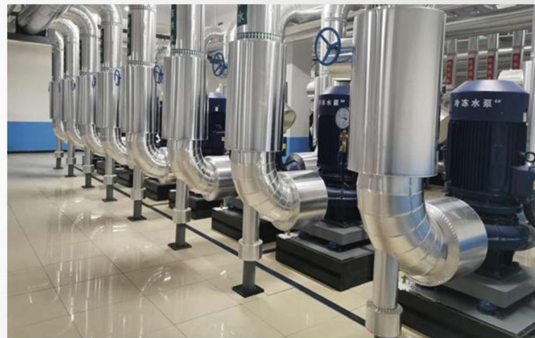
同型号、同规格设备及管道、阀门排列整齐，成排成行
