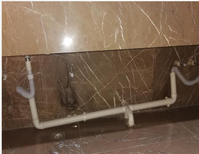
多台器具布置排水支管坡向不正确
