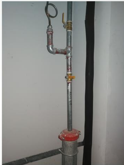
末端试装置排水管排水管直接
