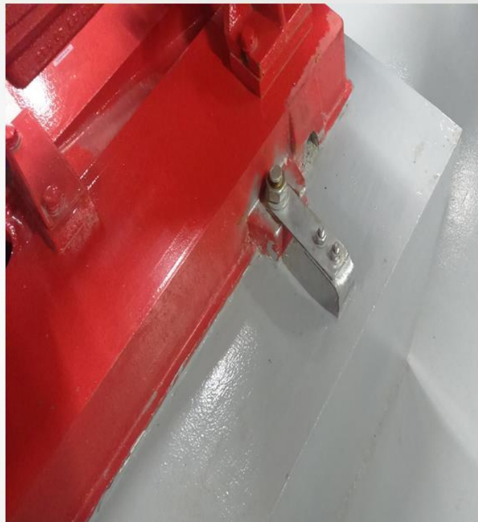
减振垫上方基座不可硬接地
