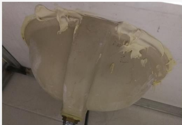
台下脸盆石材胶粘接、无托架
