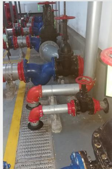
水箱溢流管、空调冷凝 水管等直接插入排水沟
