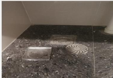
地漏水封小于50mm、地砖未套裁铺贴、坡度小于5/100
