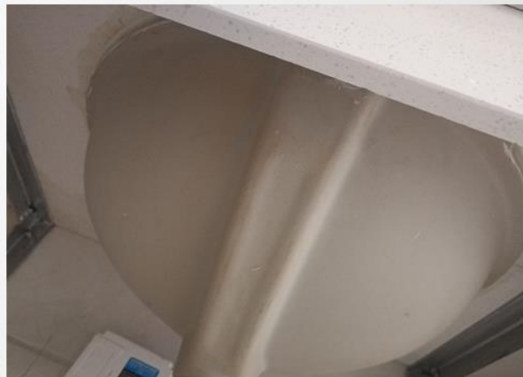
台下脸盆石材胶粘接、无托架
