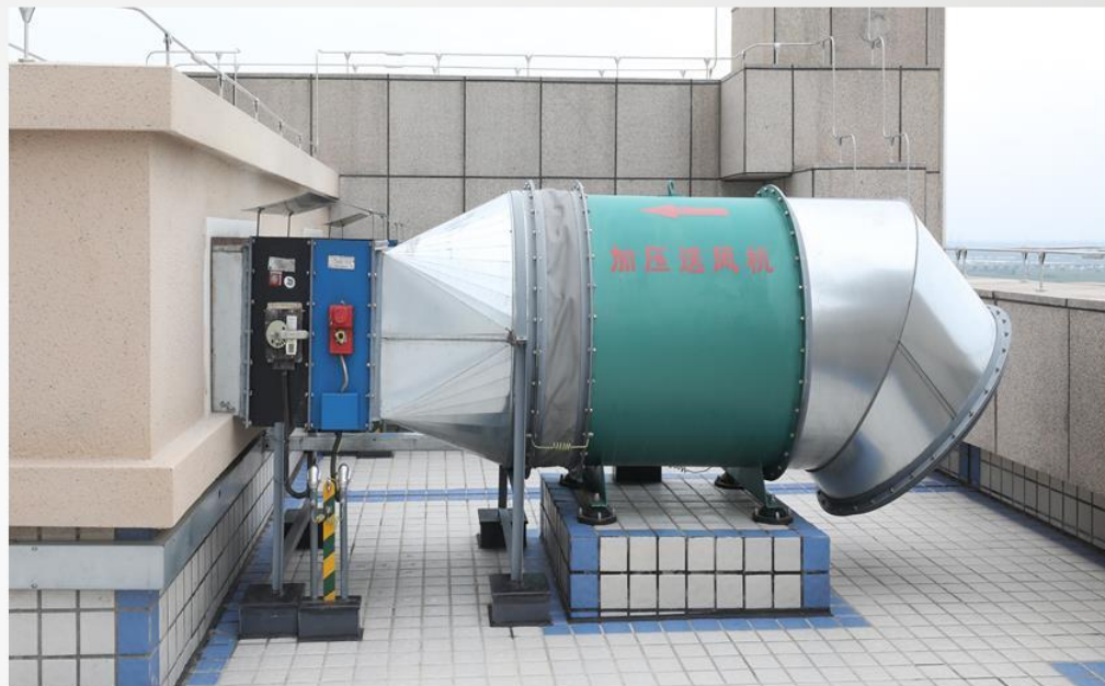
风道出风管与风机中心线安装标高一致
