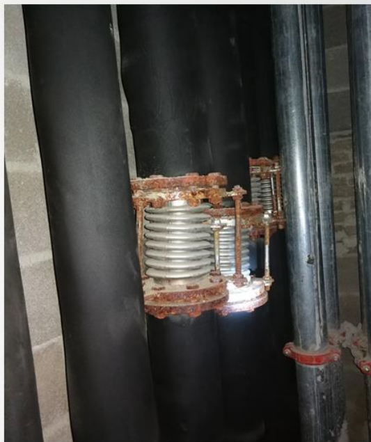
补偿器安装歪斜、限位螺杆未拆除、未保温
