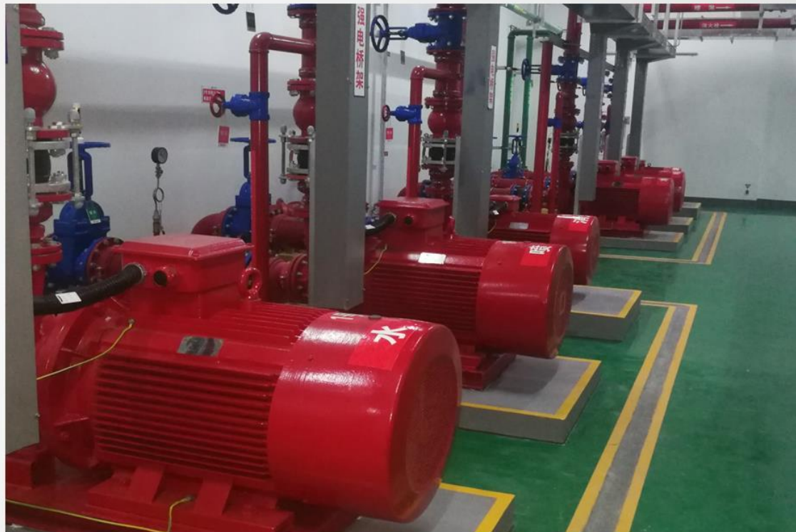
多台相同设备基础纵向顺直，成排成行。标高一致
