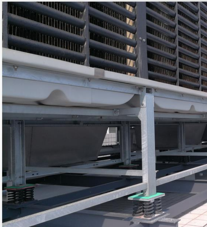
冷却塔采用弹簧减振装置
