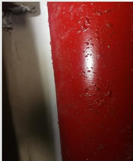
管道防腐基层未除锈、清理
