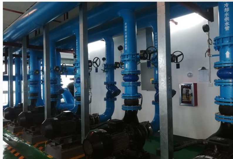
并联水泵出水管与总管连接采用顺水三通
