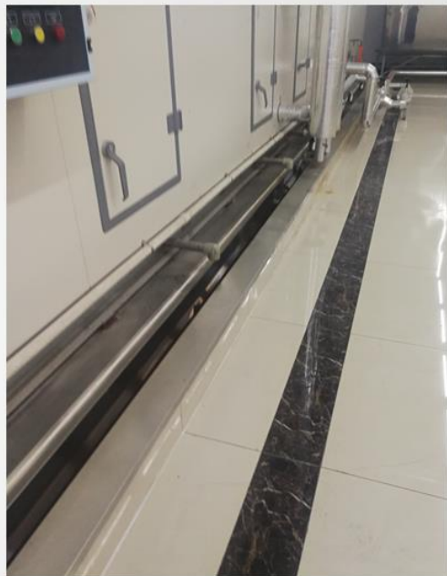
冷凝水管上未安装水封
