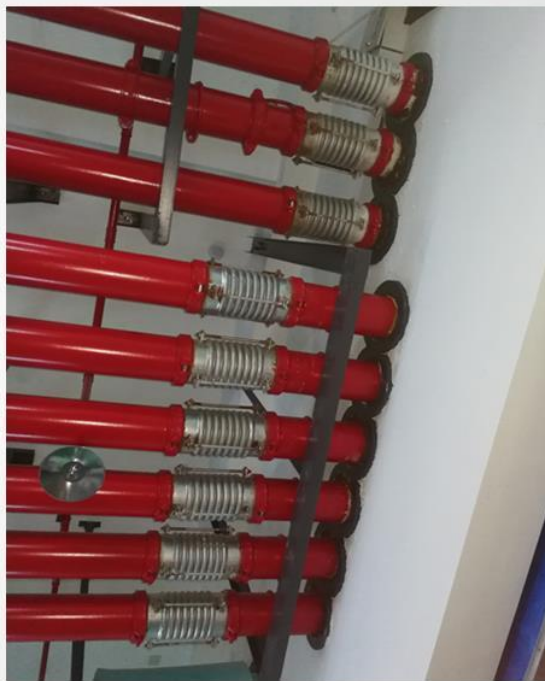
管道穿沉降缝、变形缝处理
