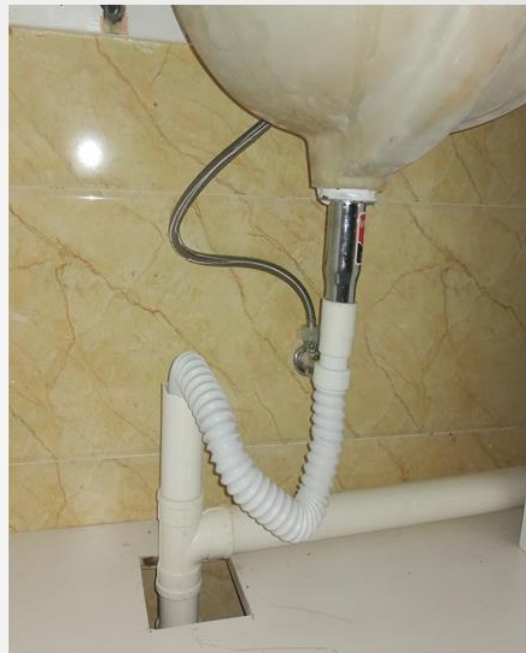
用波纹管水封，封堵也严密
