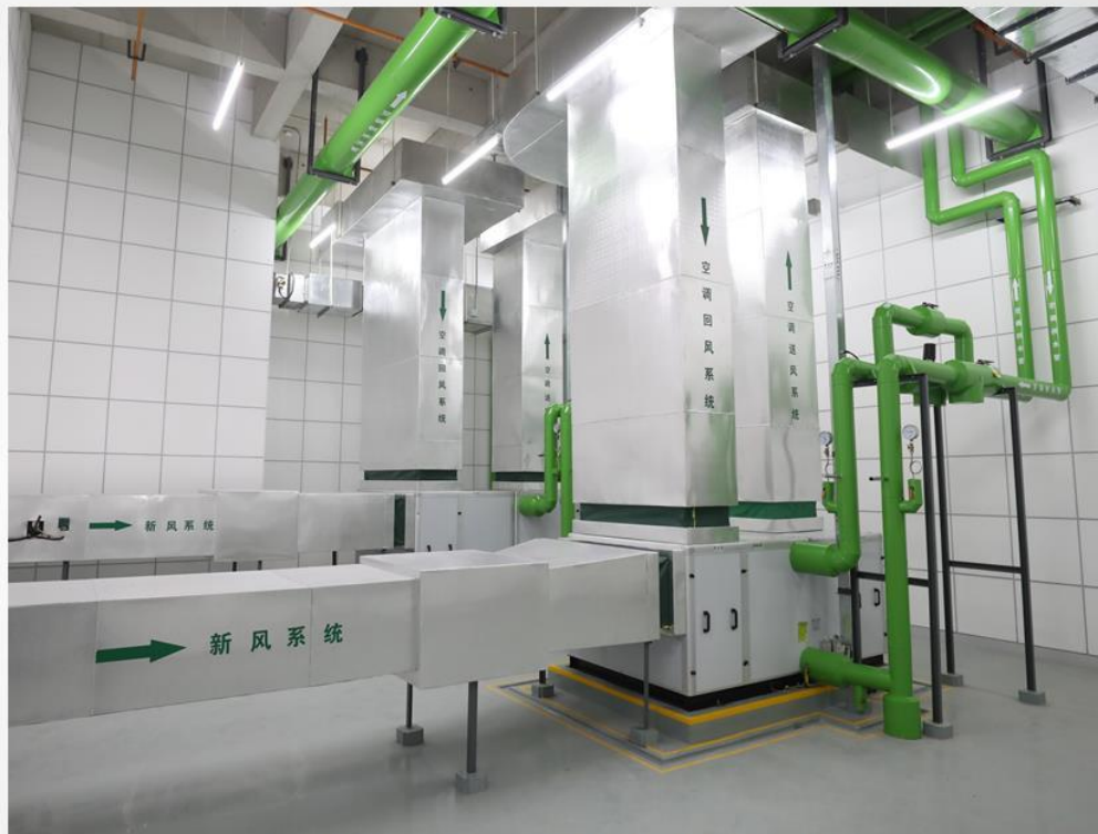
风管保温严密、保护壳平整美观、标识醒目
