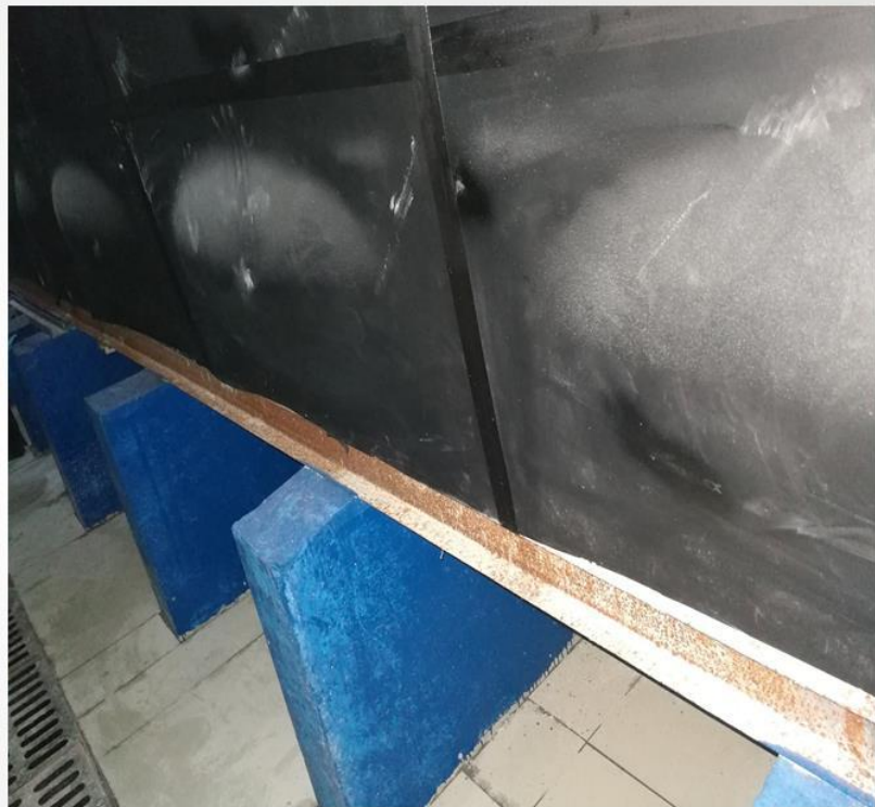
基础大小与水箱不协调，未采取防电化学腐蚀措施
