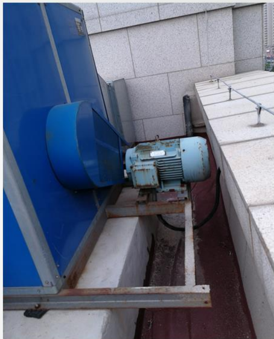
基座与基础不匹配，基座防腐不到位，设备维修空间不够、电机无防水措施
