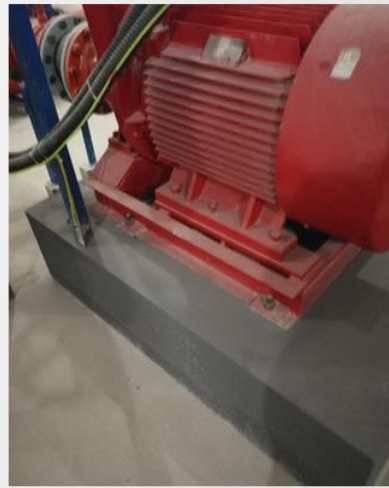
减振垫被水泥砂浆掩埋
