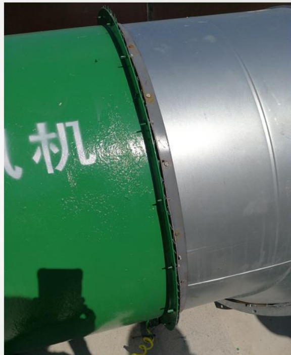
金属风管连接紧固均采用自攻螺钉
