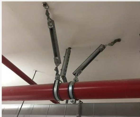
管道（刚性）按间距要求设侧向、纵向抗震支吊架
