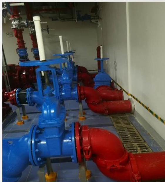
吸入管水平管段上有气囊
