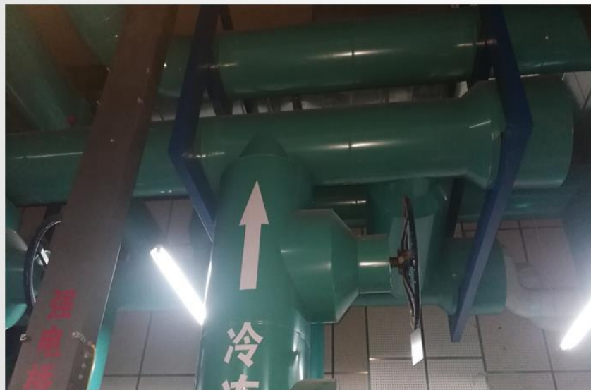
并联水泵出水管与总管连接未采用顺水三通
