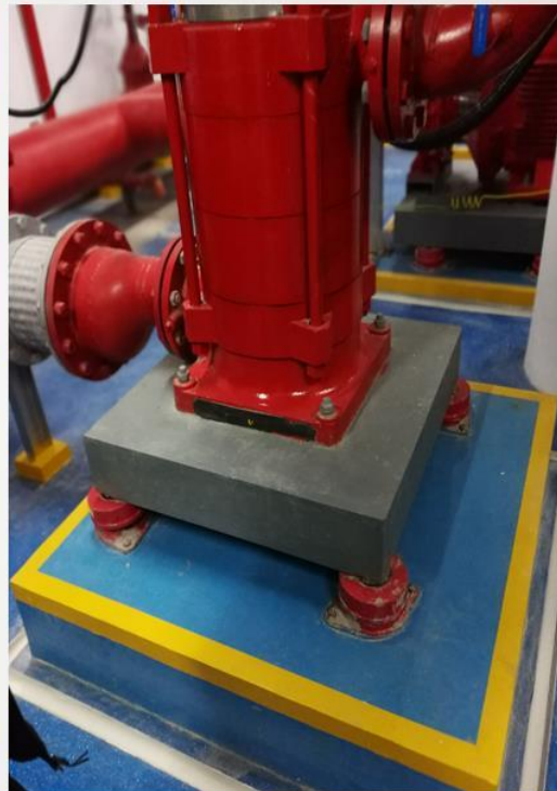
立式水泵采用弹簧减振器
