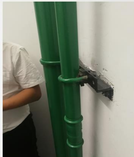
支架根部处理粗糙、面漆漏刷
