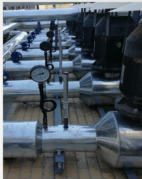
室外管道配件保温壳 采用大小头咬口封头
