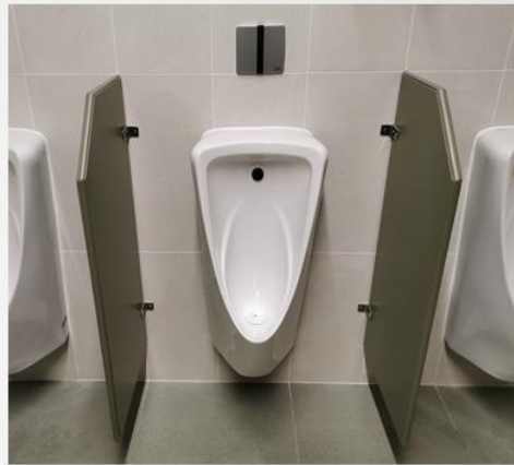
卫生器具安装端正、美观，与瓷砖居中对称
