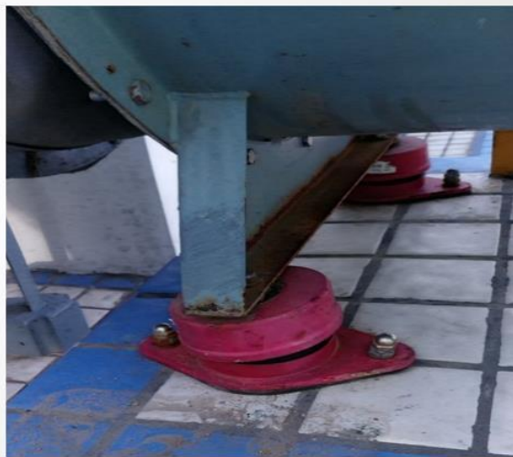
减振器安装歪斜
