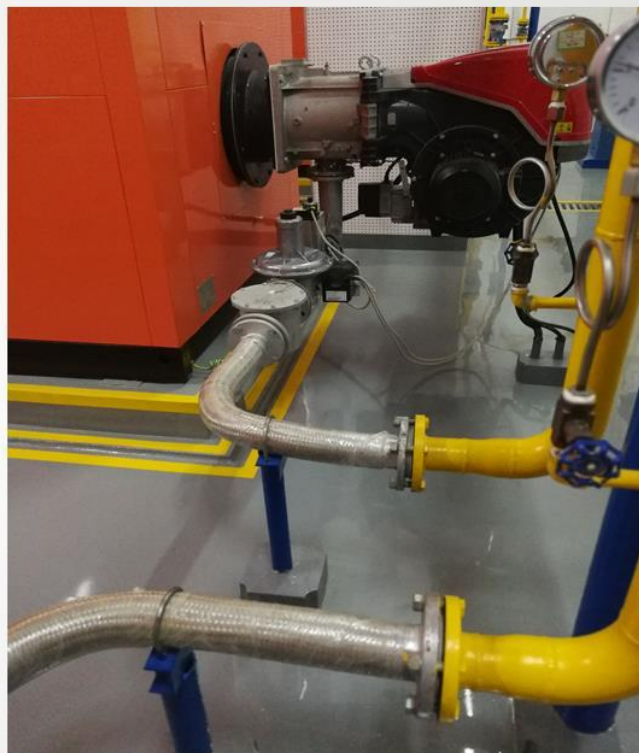
支架设在金属软接管上
