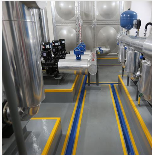
设备周围设置倒流槽、地面设有排水沟
