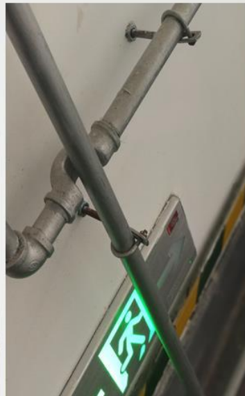
圆钢膨胀丝U形卡非标简易支架
