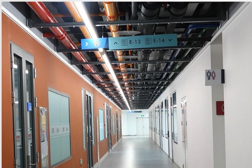
顶棚各类管道排列整齐，采用公用支架，布置合理
