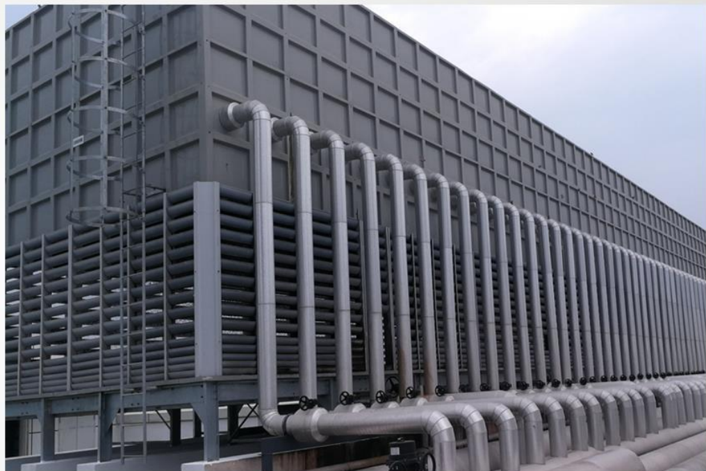
冷却塔进水支管
