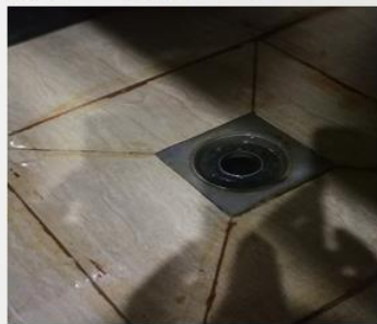
地漏水封小于50mm
