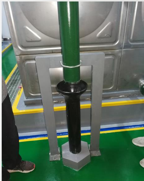
溢流管间接排水设独立支架
