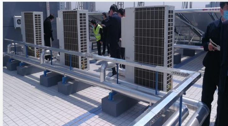
冷媒管排列整齐、保温严密平整
