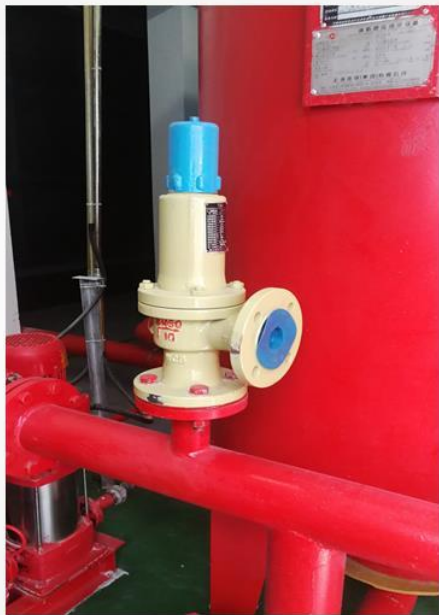
安全阀的泄压口未引向排水沟或集水井, 直接排放
