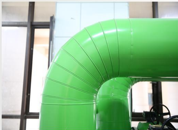
分节制作的虾米腰形式连接严密、美观
