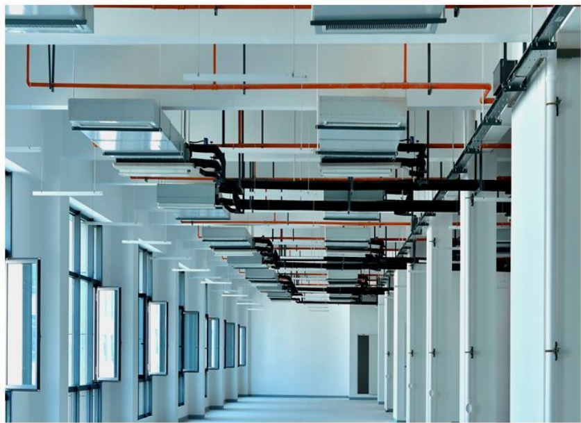
风管安装应顺直、牢固，接口严密，表面平整，无变形、扭曲
