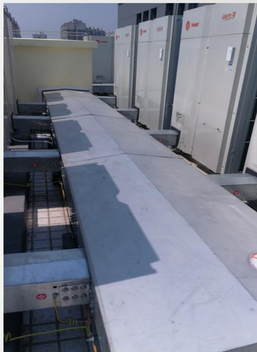
冷媒管管槽内，人字形盖板、槽底设置排水孔
