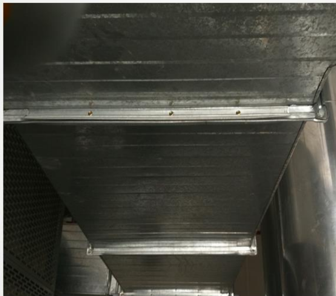
金属风管连接紧固均采用自攻螺钉
