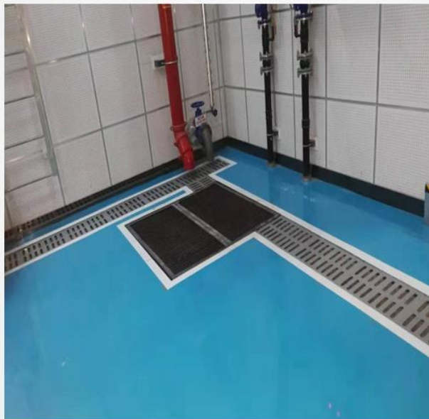
设备周围设置倒流槽、地面设有排水沟
