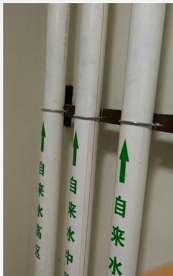
塑料管道碳素钢支架无隔离措施
