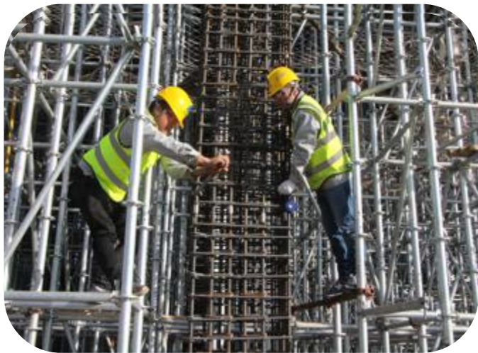
直螺纹套筒力矩现场检测
