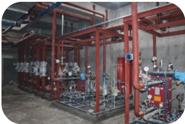
换热 机组 模块 安装
