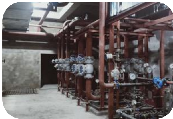
热 水 循 环 泵 模 块 安 装
