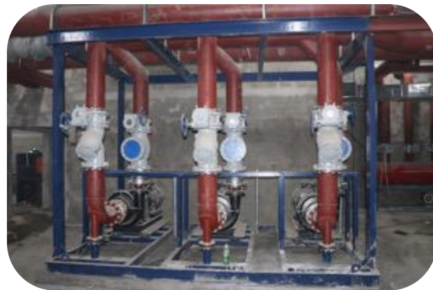
空 调 循 环 泵 模 块 安 装
