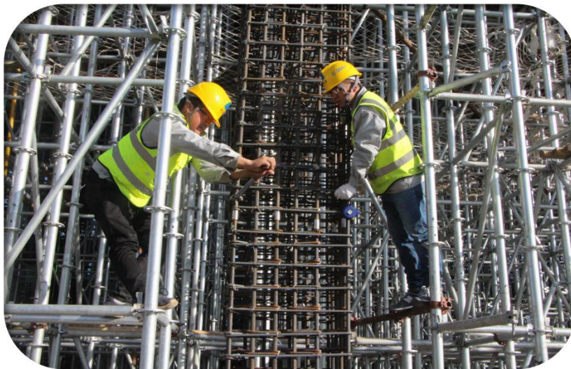
钢筋机械连接质量检查
