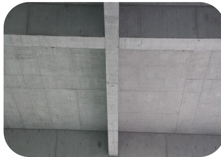
混凝土内实外光、阴阳角方正、棱角顺直
