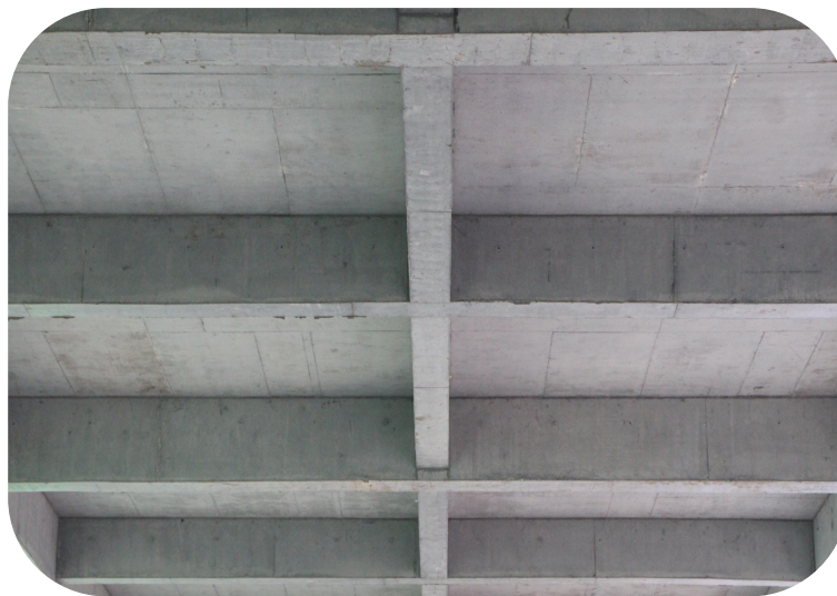
混凝土内实外光、阴阳角方正、棱角顺直
