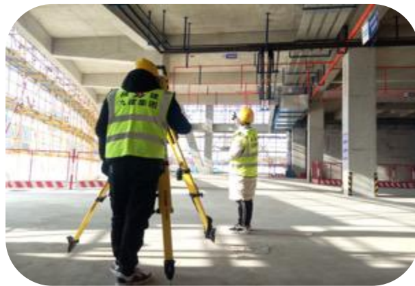
人 工 配 合 机 器 人 现 场 放 线
