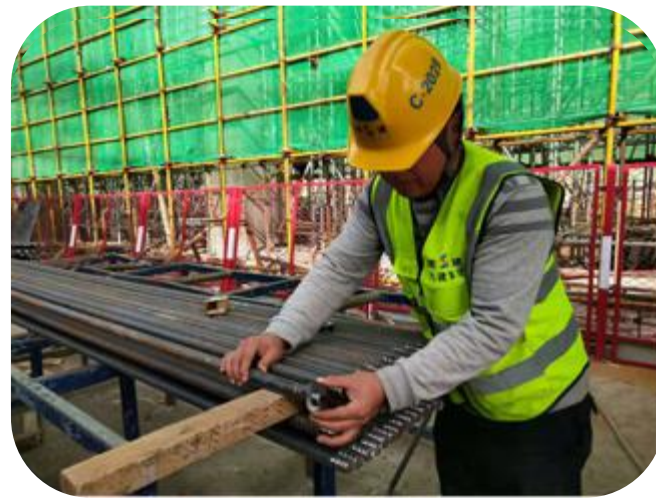
通、止规检查钢筋直螺纹套丝长度
