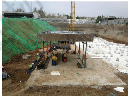
加工车间垫层一次浇筑成型
