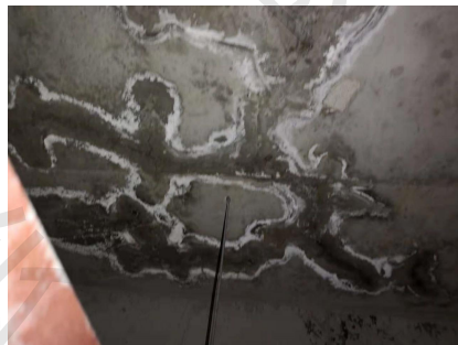
结构板渗点不等于防水渗漏点
