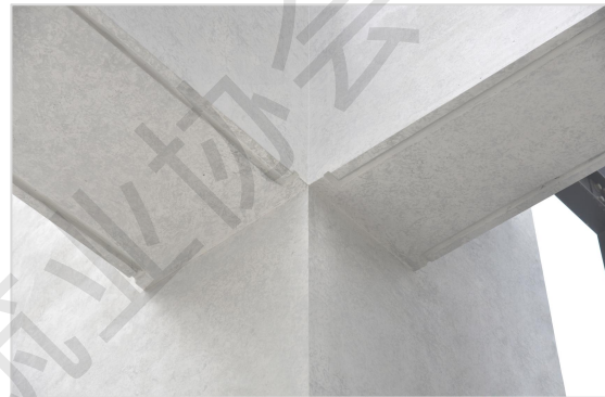
预埋半圆木条 滴水线结构成型
