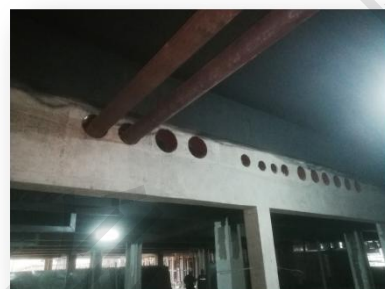
填充墙穿套管部位下挂梁优 化一次成活
