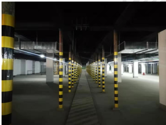
后浇带废旧泵管独立支撑一次成活
