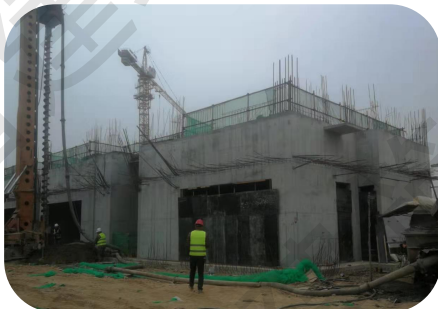
车库连接施工缝留置在外墙，渗漏隐患大
