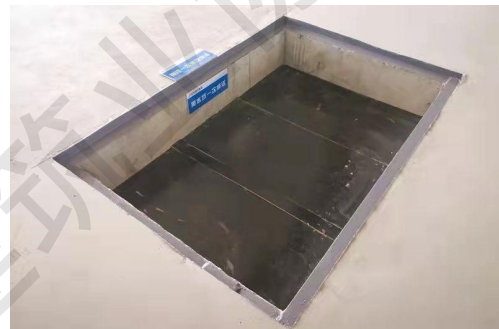
集水坑角铁预埋一次成型
