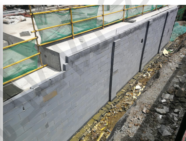
外架拆除前砌筑完成
