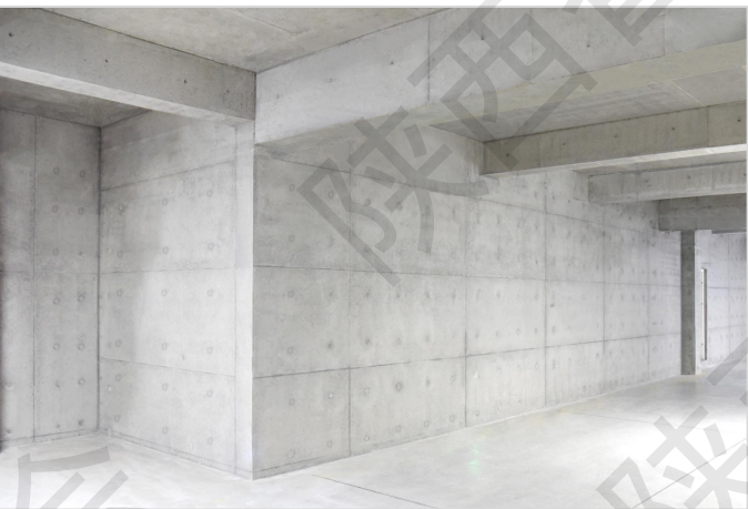
地下车库墙面平整、棱角方正
