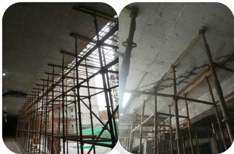
后浇带悬臂构件裂缝、渗漏
