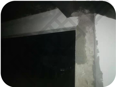
防火卷帘门构造柱后浇
