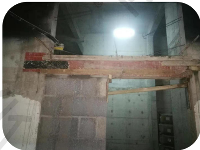
门洞现浇过梁工序复杂
