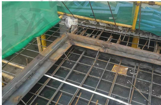
转角止水钢板连接
