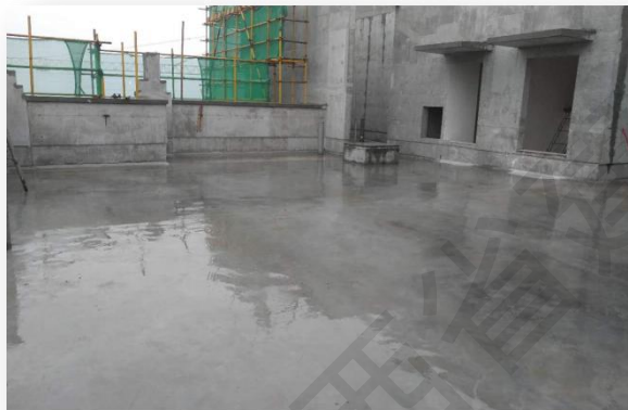
屋面结构找坡成型
