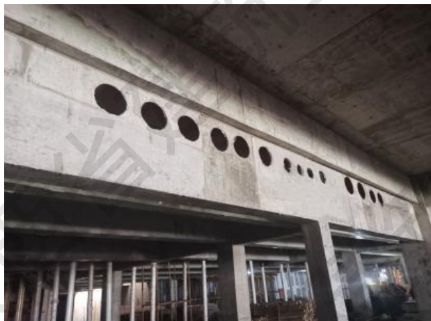
结构穿墙套管精准预埋
