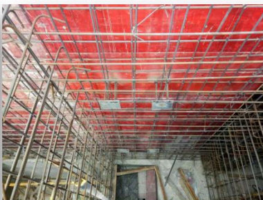
检修梯支座钢板精准定位
