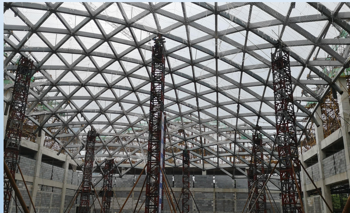
训练馆顶升施工
