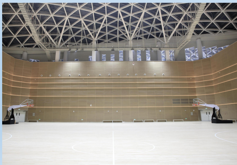
木纹转印吸音板安装牢靠
