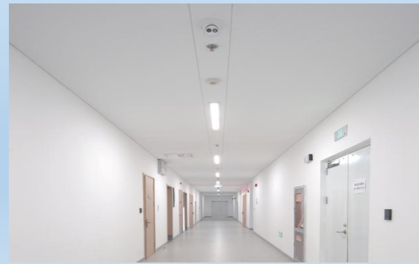
石膏板吊顶末端装置成排成线
