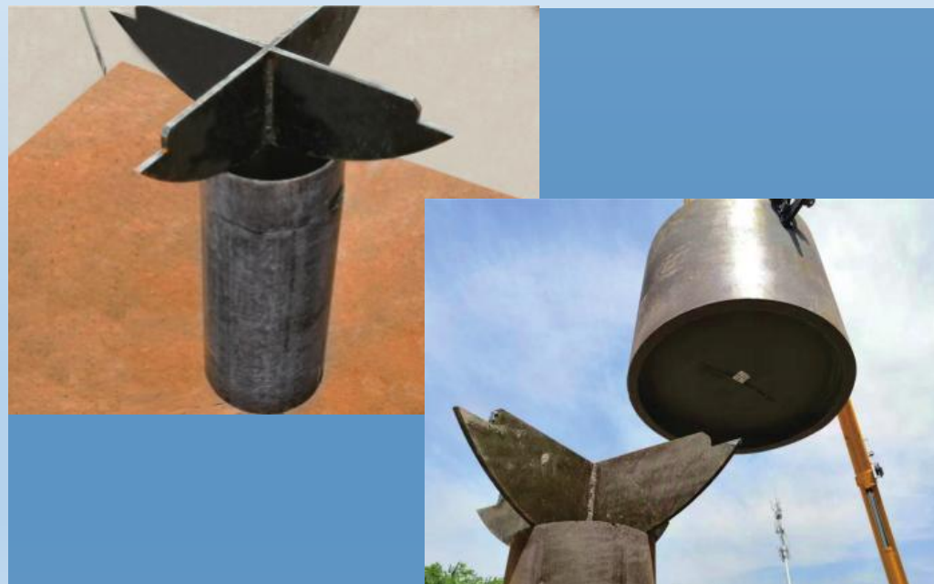
榫型节点定位装置
