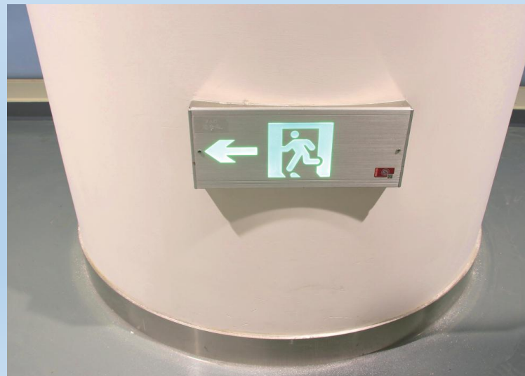
安全疏散指示灯弧形定制安装
