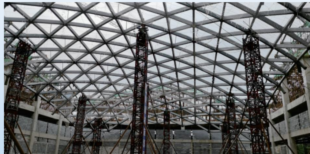
单层网壳顶升施工
