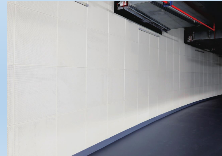
穿孔吸音铝板墙面通畅顺直
