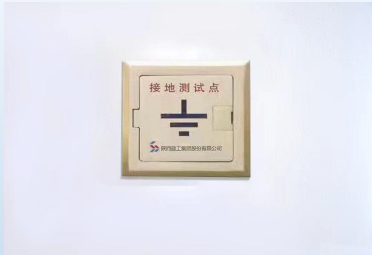
接地测试点标识醒目
