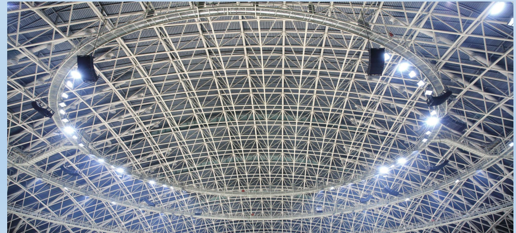
双层网壳钢结构安装安全可靠
