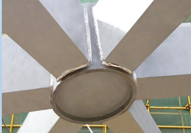
鞍节点焊缝饱满
