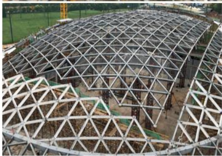
训练馆顶升施工
