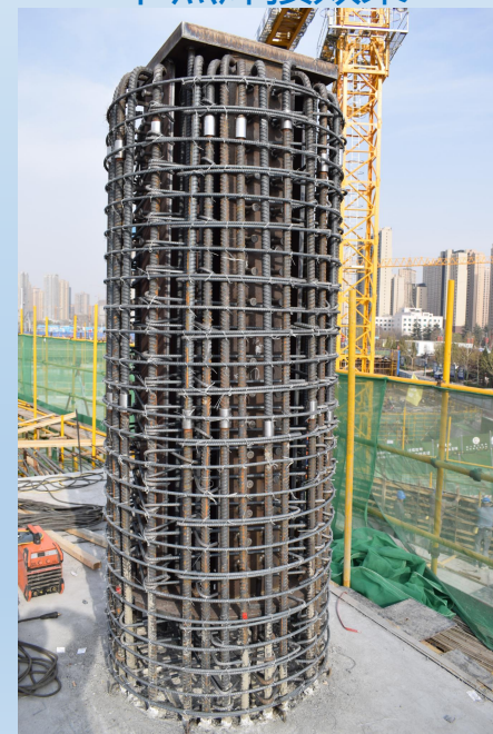
型钢柱钢筋绑扎效果
