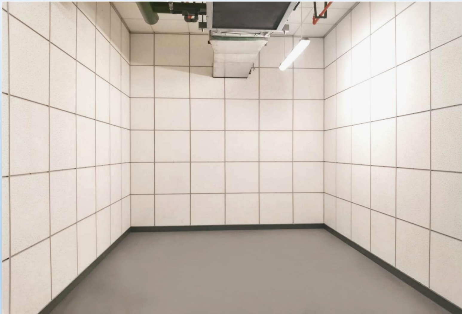
吸音板安装平整
