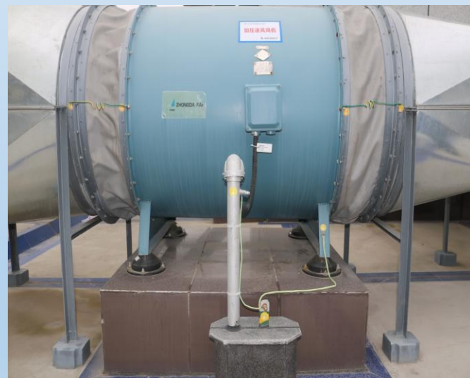
屋面设备接地、柔性接头跨界牢固
