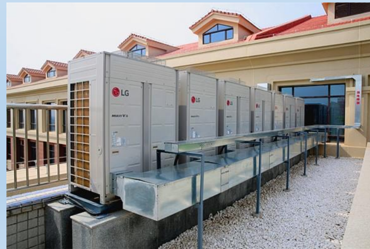
多联机外机冷媒管管槽敷设，整洁美观
