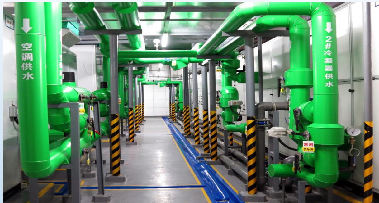
空调设备与管道连接严密，保温平整
