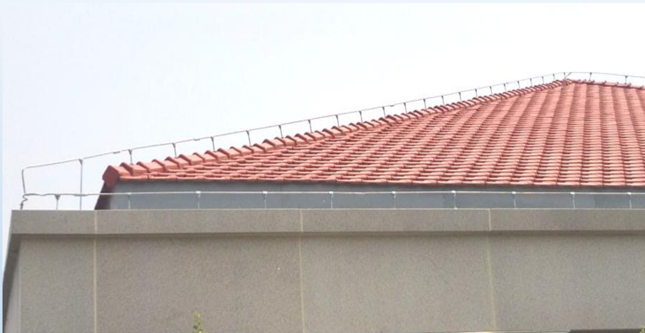
瓦屋面接闪带沿脊线敷设顺直、牢固
