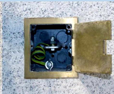
防雷引下线焊接可靠，接地测试点实用、美观，标识醒目
