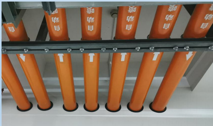
管道穿墙根部加装饰圈处理精细
