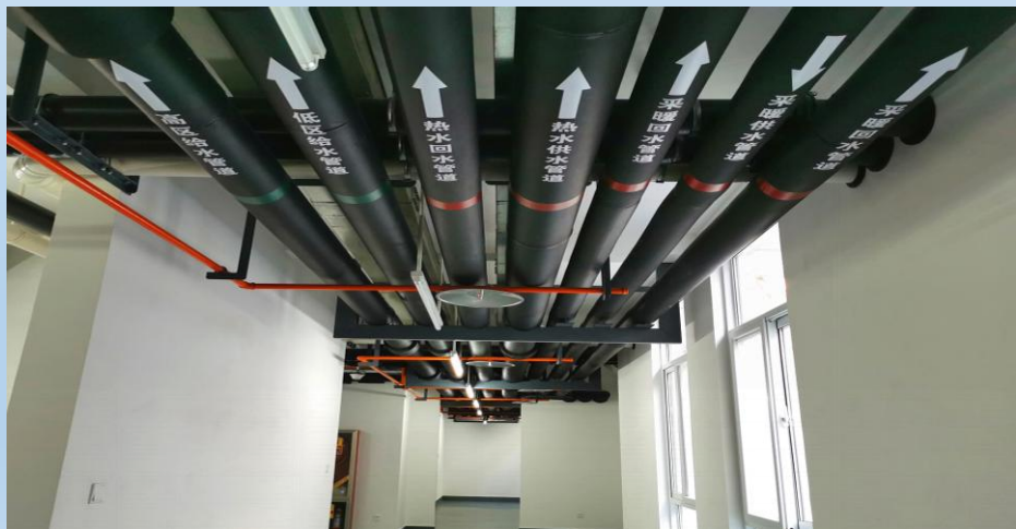
管道排列整齐、安装牢固、保温严密、标识醒目
