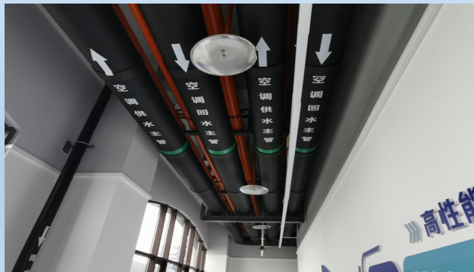
管道排布整齐，橡塑保温严密平整、标识清晰
