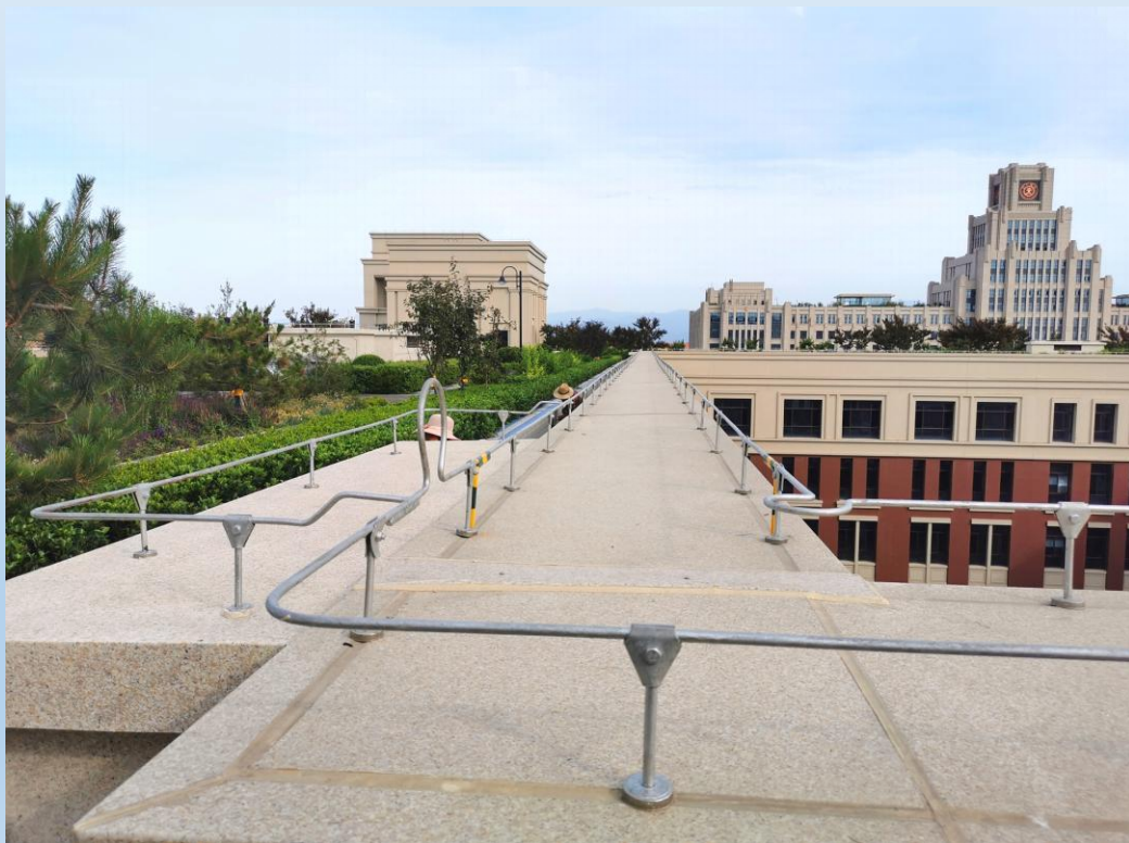
接闪带敷设平整，支架间距均匀、牢固
