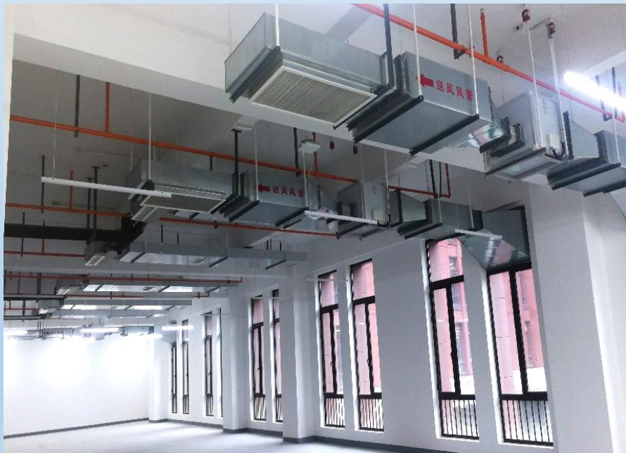
实验室各类管道、灯具、喷头、管口排列整齐
