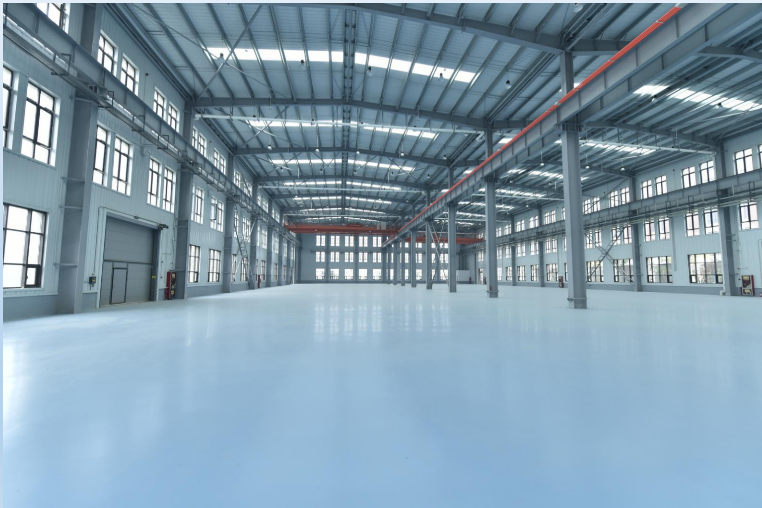
钢构实验室自流平地面平整洁净
