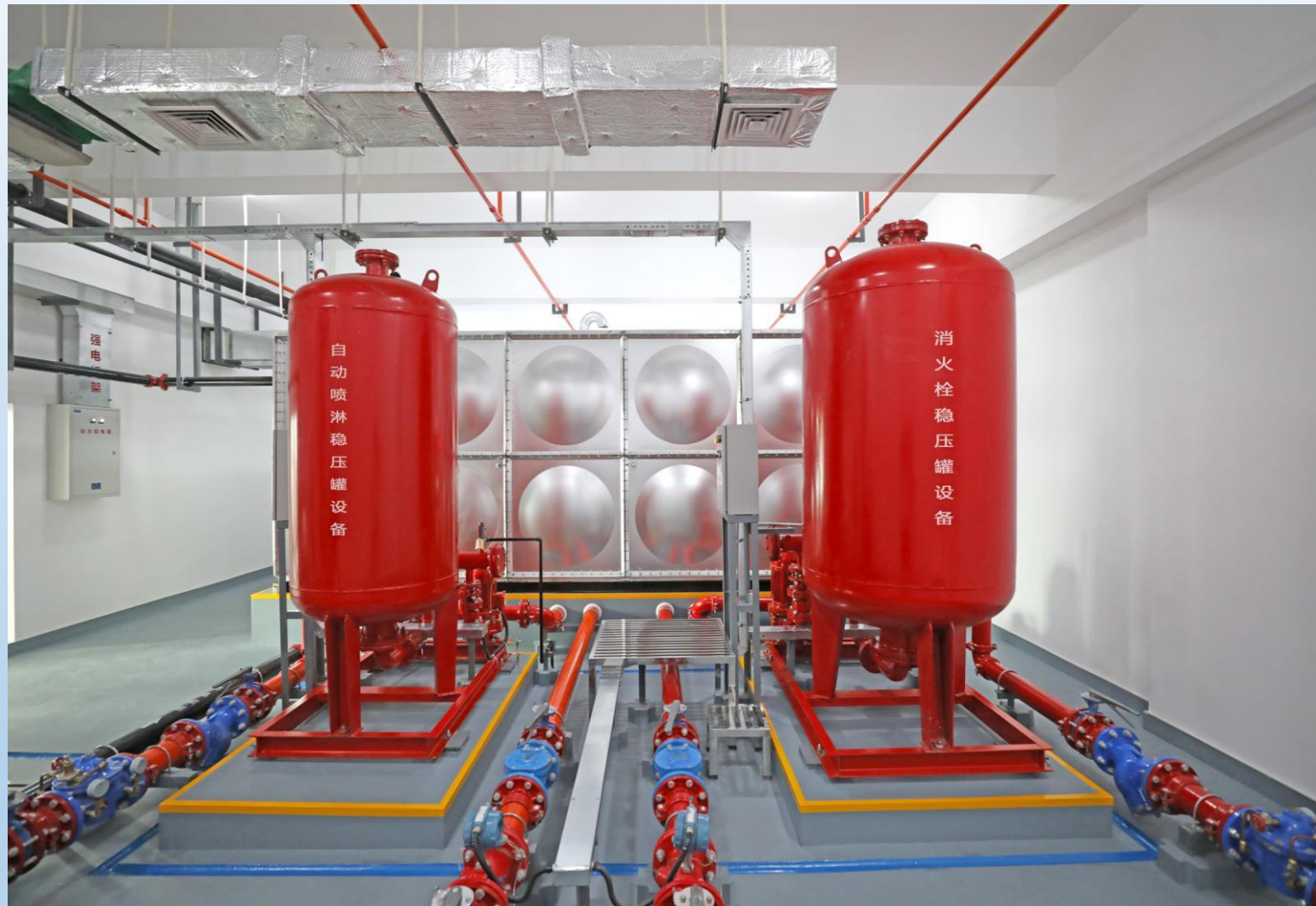
消防稳压设备安装牢固、管道连接严密
