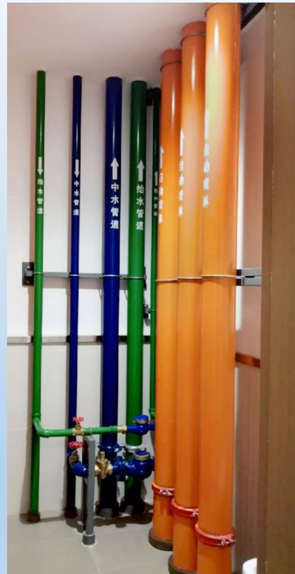
管井内管道布置有序、标识醒目
