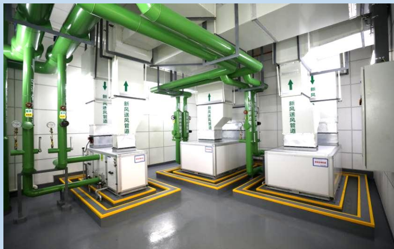
新风机组安装稳固，标识醒
