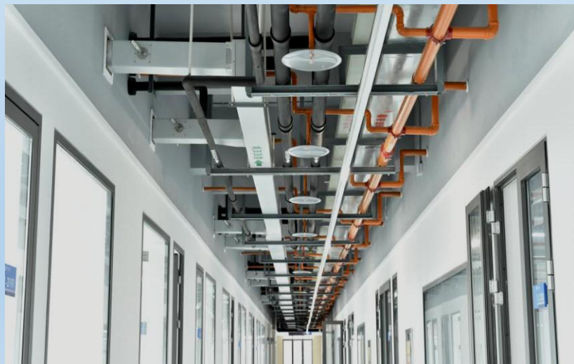
新风风管布置合理、支管过墙处理细腻
