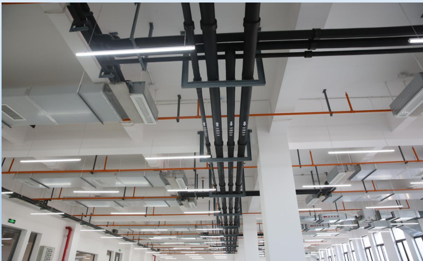
风机盘管机组布局合理，配管排布整齐
