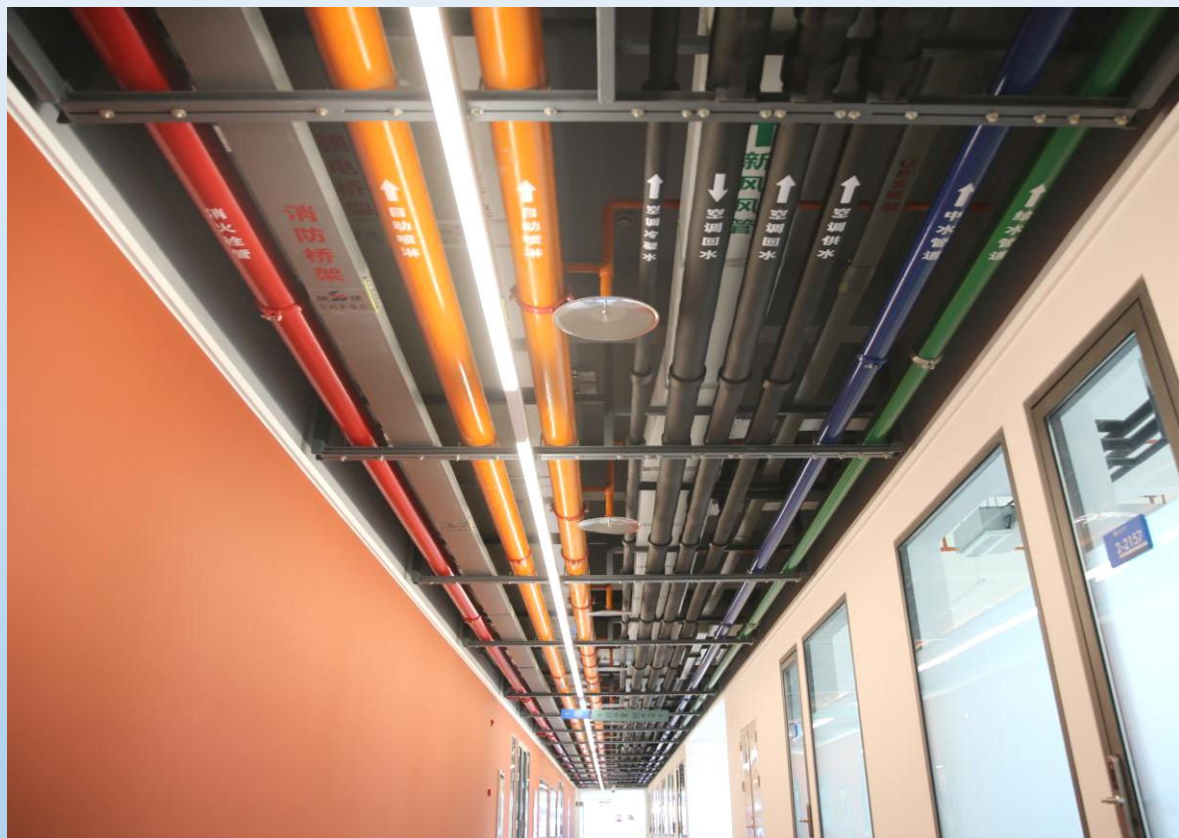
无吊顶走廊各类管道、槽盒、梯架、安装牢固、成排成行标识齐全
