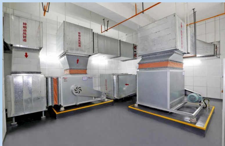
排风排烟设备安装稳固，风管连接严密
