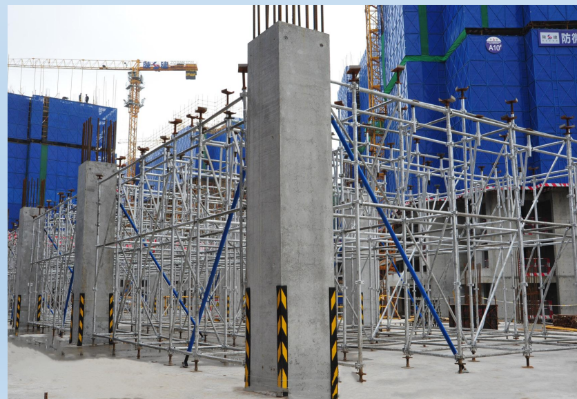
15#楼预制装配式框架结构柱安装
