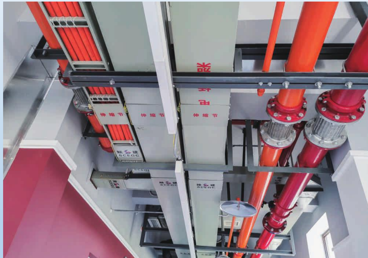
管线穿变形缝处理合理，综合支架，安装规范
