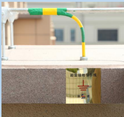
防雷引下线焊接可靠，接地测试点实用、美观，标识醒目
