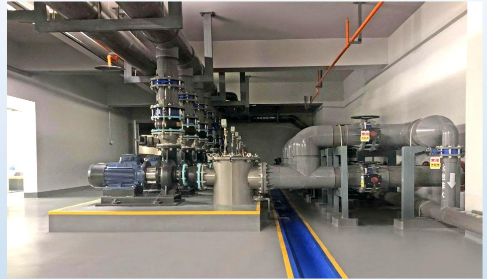
给水设备管道连接严密，机房有组织排水
