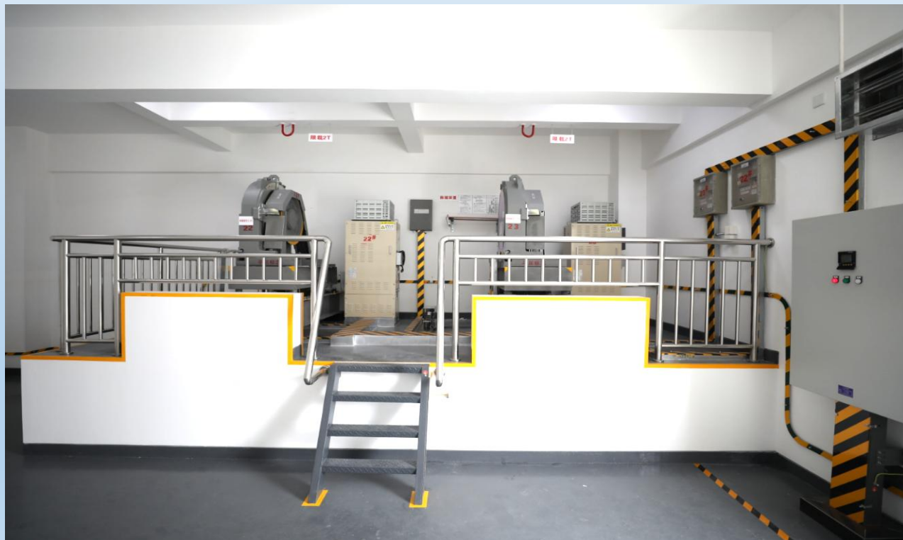
曳引机安装牢固、运行平稳
