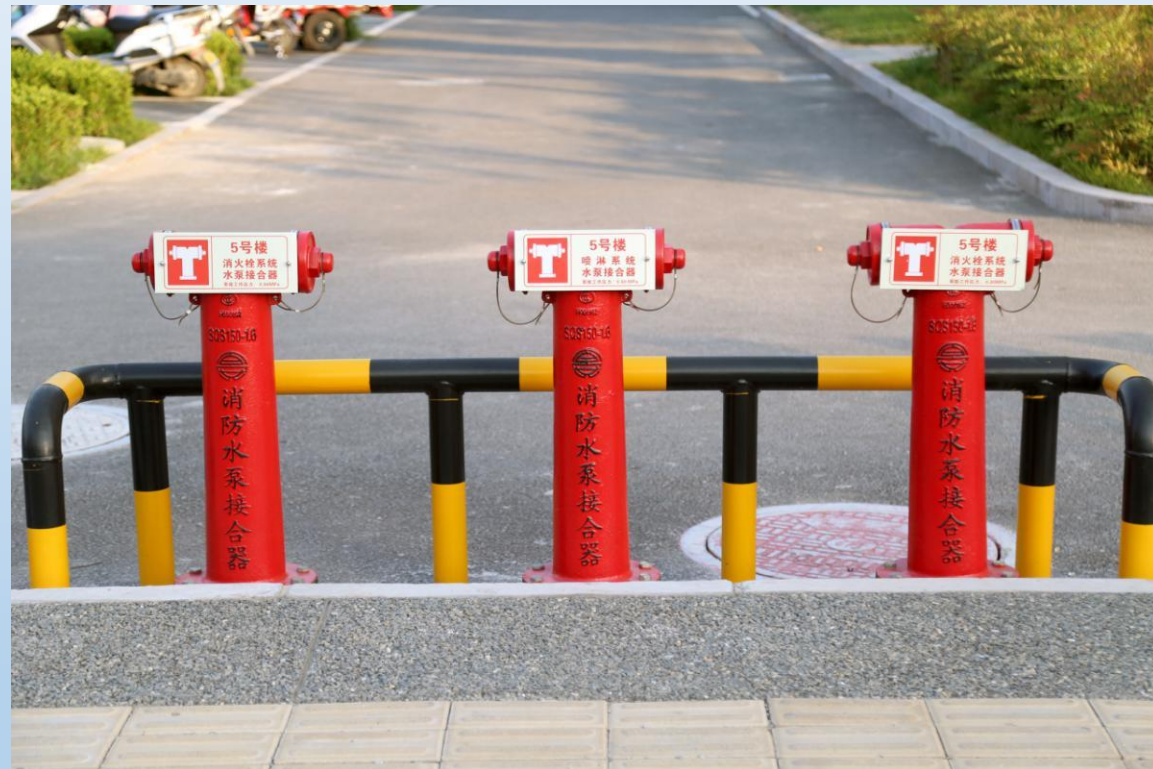
水泵接合器安装牢固、标识醒目、保护到位
