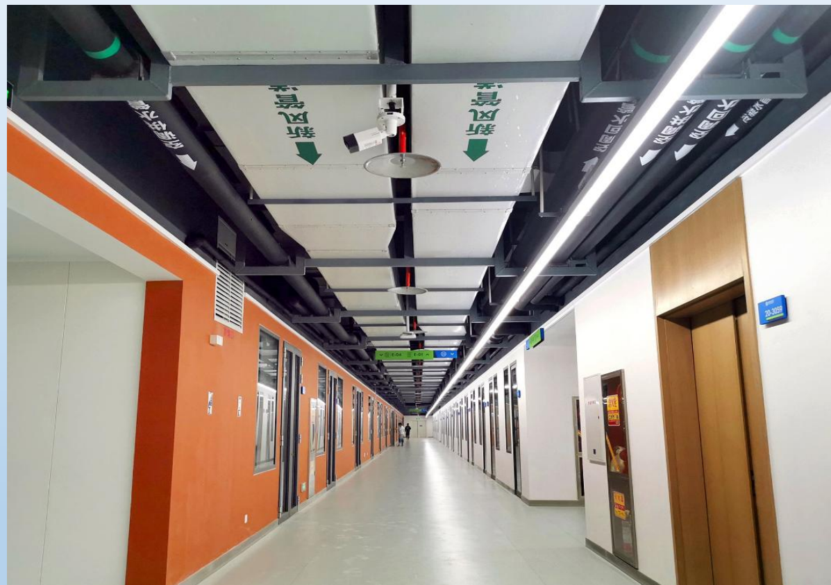
无吊顶走廊风管、管道排列整齐、标识齐全
