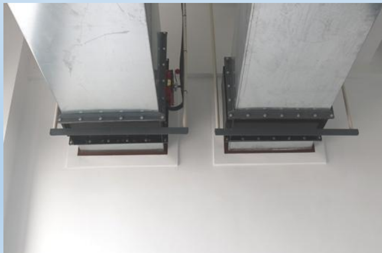
风管穿防火隔离墙，封堵严密
