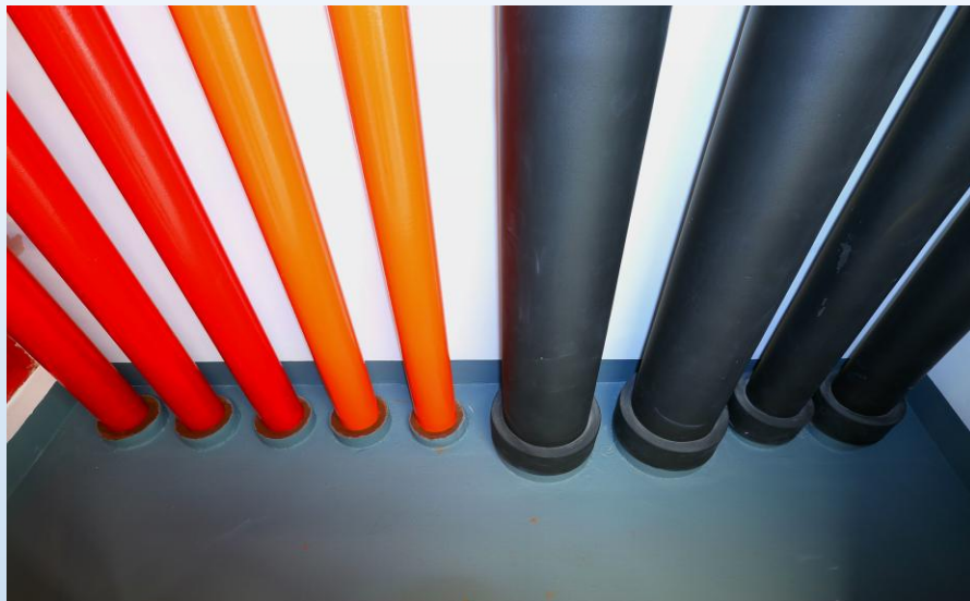
管道油漆光亮、穿楼板与套管同心，封堵严密
