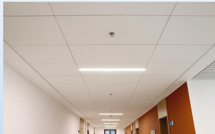
吊顶接缝平整、缝路顺直
