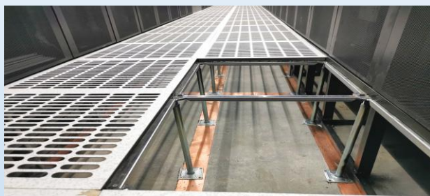
静电地板铜带接地牢靠
