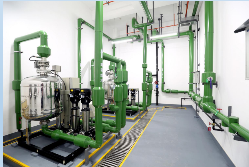
给水设备管道连接严密，机房有组织排水
