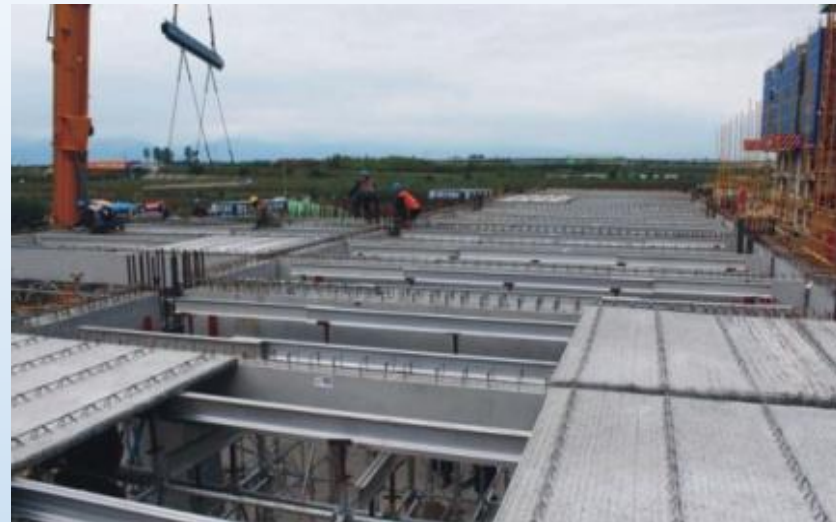
15#楼预制装配式框架结构梁般安装
