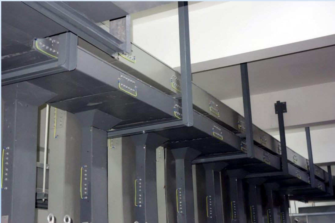
电缆槽盒、梯架采用黄绿相间多股软铜线接地跨接牢固可靠
