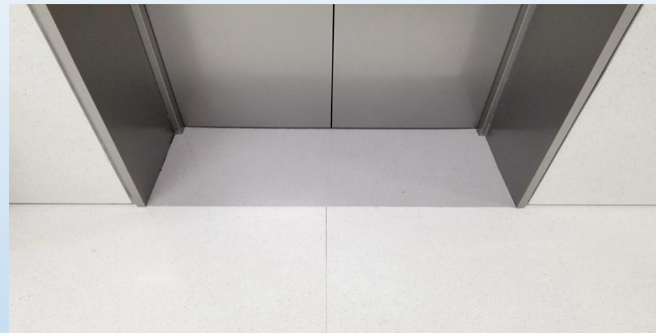
石材拼缝与电梯门居中对缝
