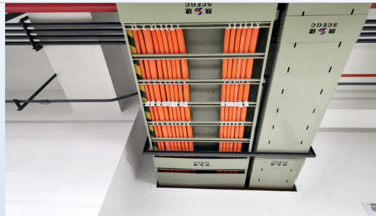
穿墙处理精细，防火封堵严密
