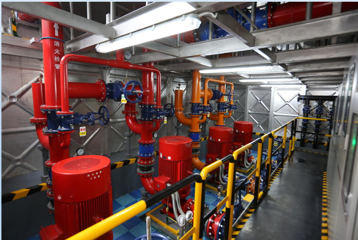
地埋式箱式拼装一体化泵房
