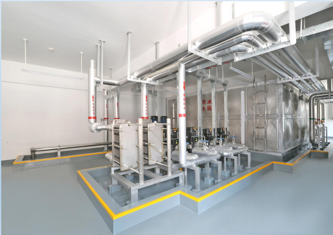
太阳能热水泵房及水箱间布置合理、排列整齐
