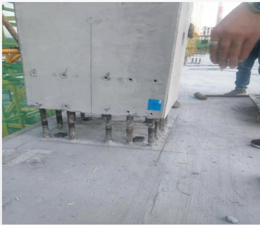
预制柱连接（钢筋灌浆套筒连接）
