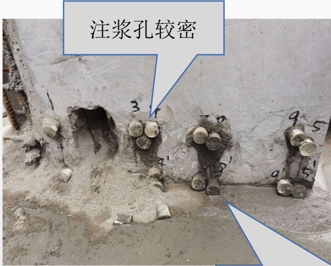
漿孔留置太低，橡膠塞難以封堵
