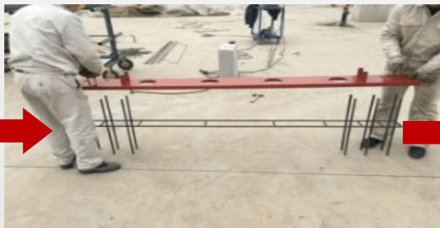
套筒插筋的焊接
