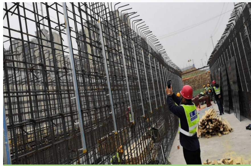
地下室外墙水平筋外置
