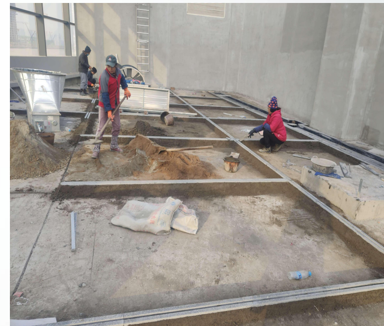
石材分隔条施工过程
