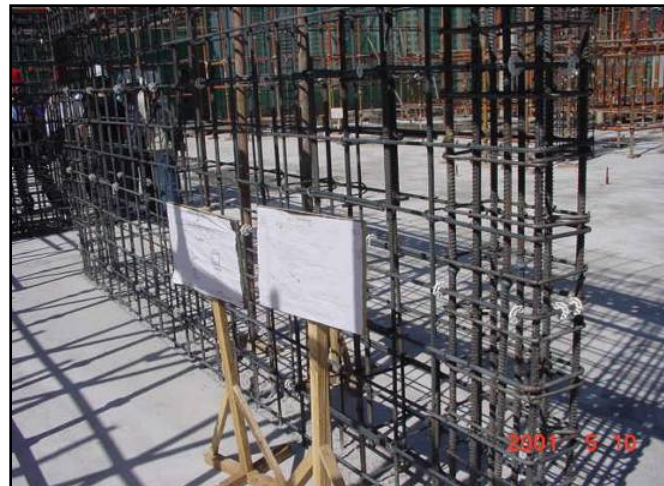
混凝土剪力墙样板
