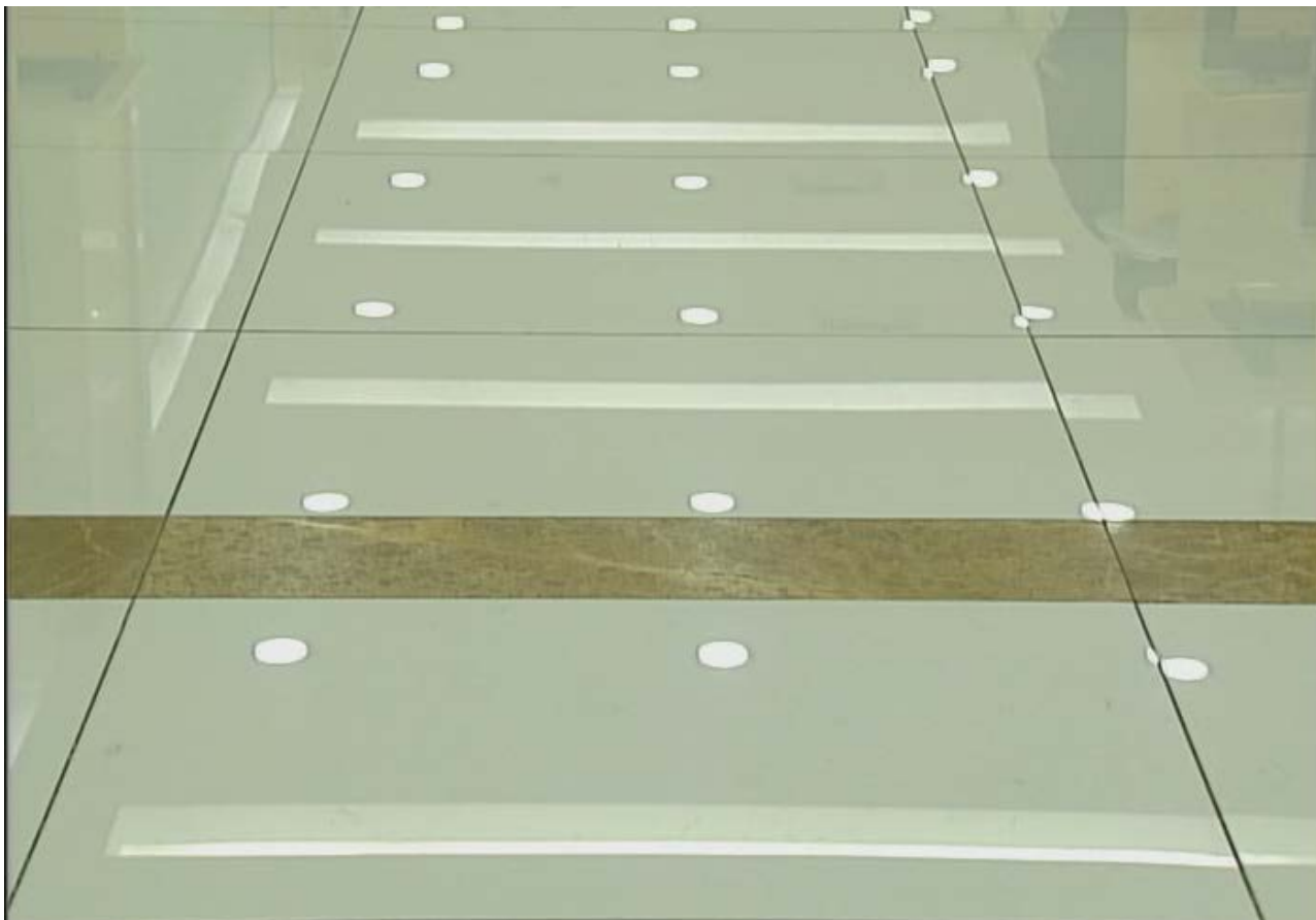
玻化砖地面拼缝严密，平整
