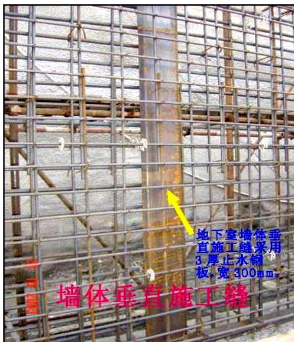
墙体垂直施工缝
