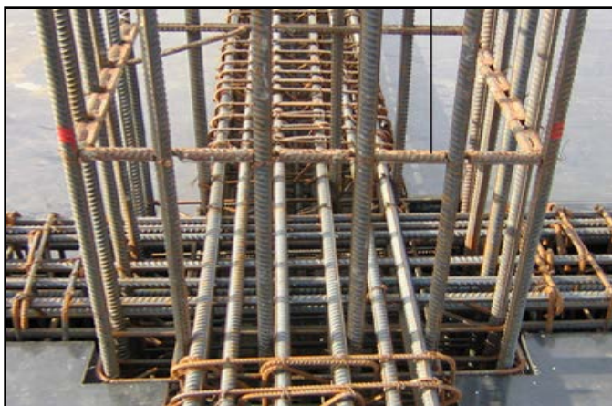
梁柱接头钢筋绑扎
