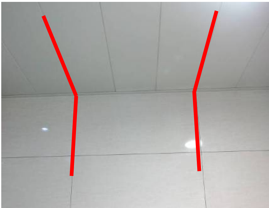
卫生间吊顶铝板与墙砖缝对齐
