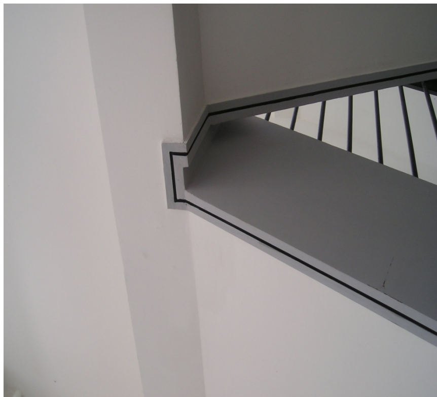
梯板滴水线轮廓分明，滴水线槽顺直，宽窄一致
