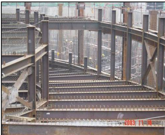
钢结构车道安装
