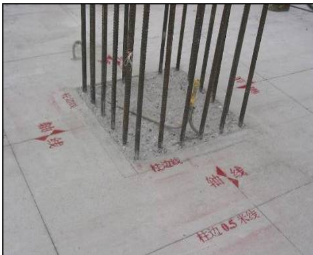
弹柱边线、切边、剔除软弱层
