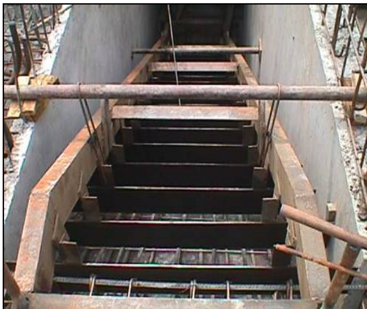
固定校正后的整体式楼梯模板
