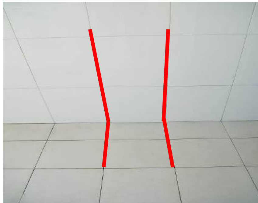
墙面砖缝与地面砖缝对齐
