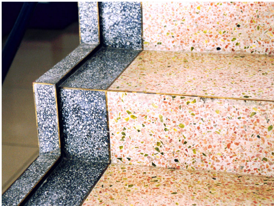
水磨石楼梯踏步齿角整齐，阳角镶嵌铜条
