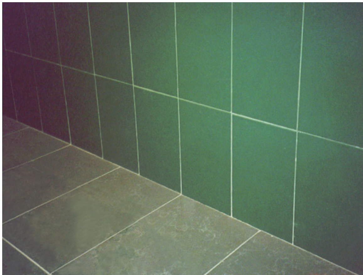
地砖与墙面砖隔块对缝
