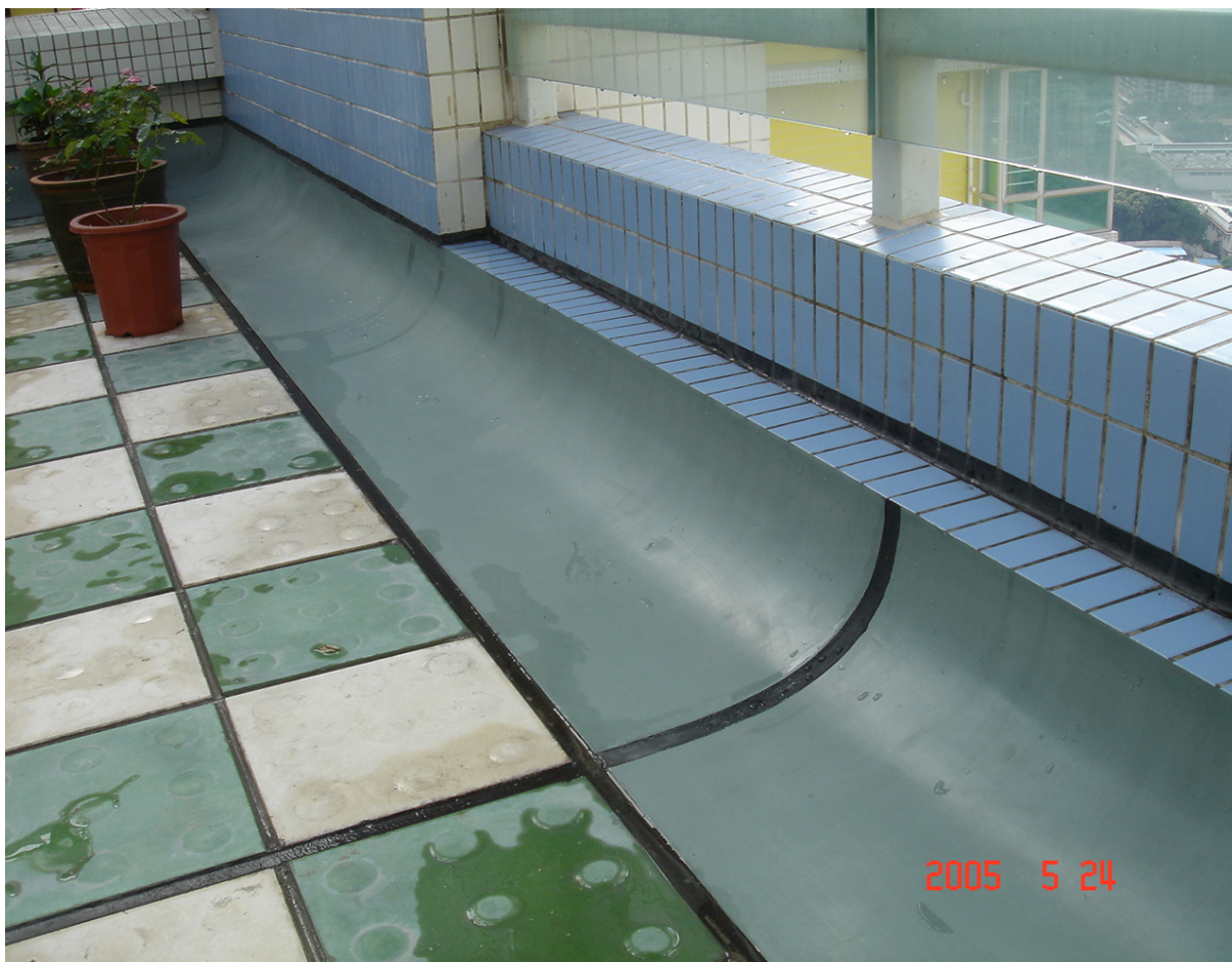
泛水高度符合设计要求顺直流畅
