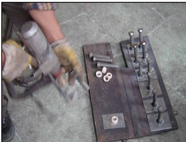
栓钉焊接穿透焊准备
