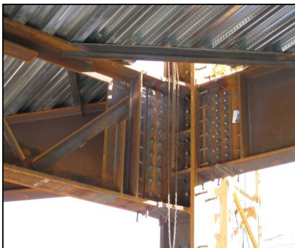
柱边角钢支撑连接
