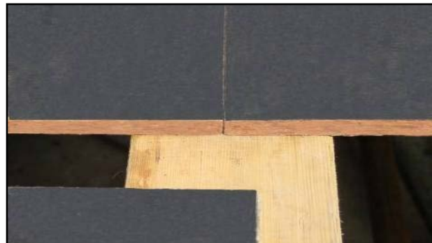
顶板模板采用硬拼缝
