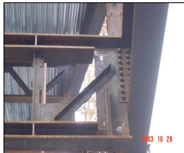
桁架与框架梁连接
