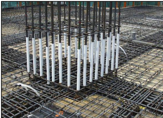
混凝土浇筑前对柱筋防污染的措施
