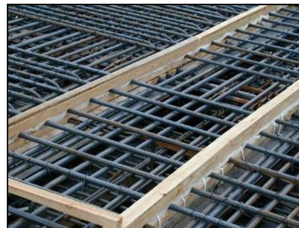
施工缝模板
