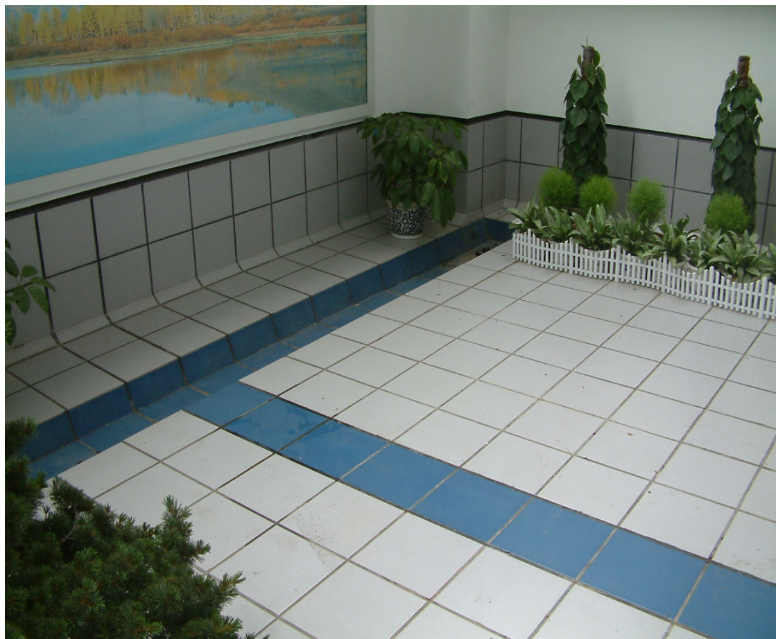
花园屋面面砖平整方正，泛水部位面砖镶贴高度一致
