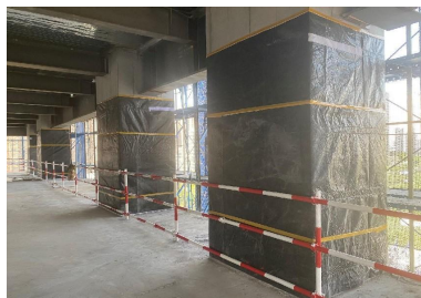
竖向混凝土构件养护
