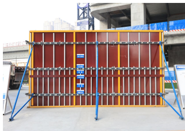
模板免打孔施工工艺
