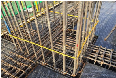
框柱钢筋采用定位卡
