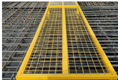
铺设马道保护成品钢筋
