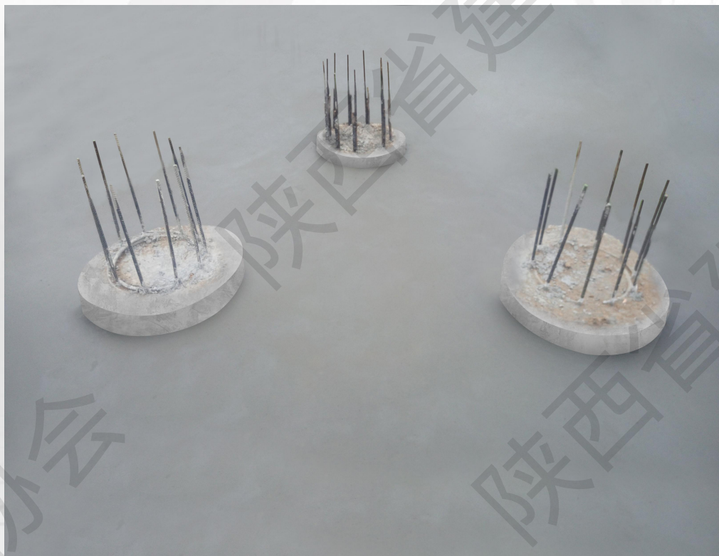
桩头钢筋顺直，锚固长度符合规范要求
