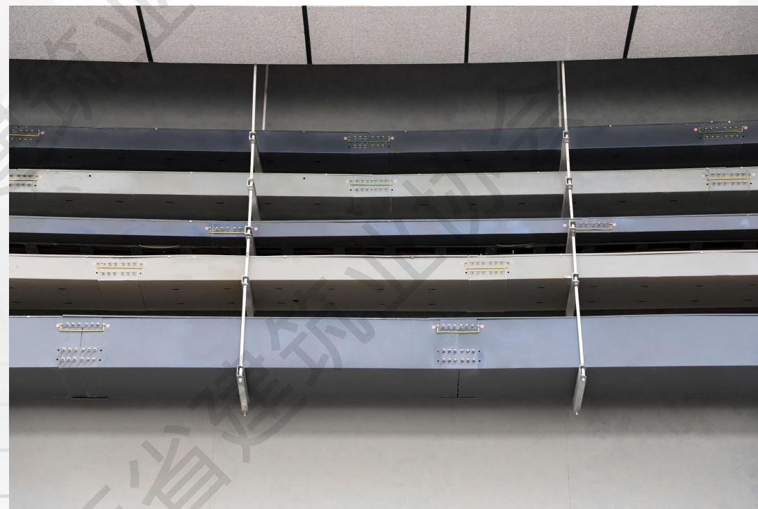
弧形管道、桥架立体分层
