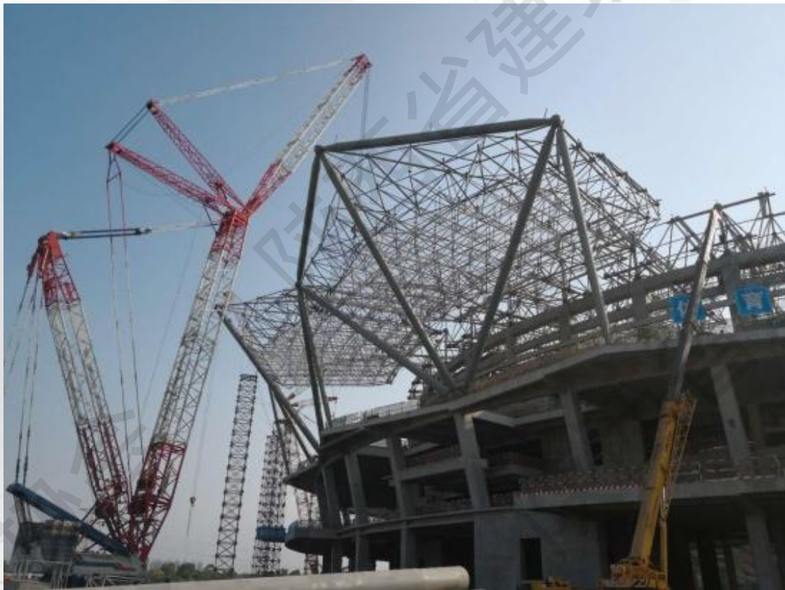
外圈钢结构吊装
