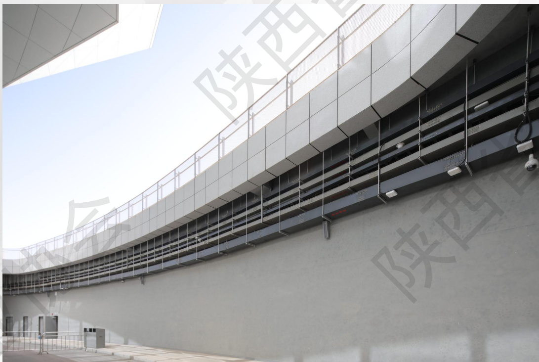
弧形管道、桥架立体分层
