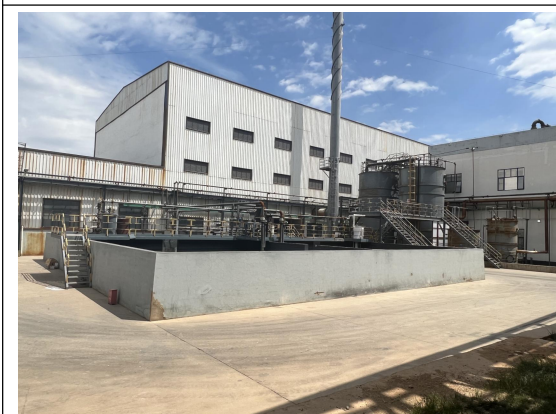
氯化钙工段区氯化钙池
