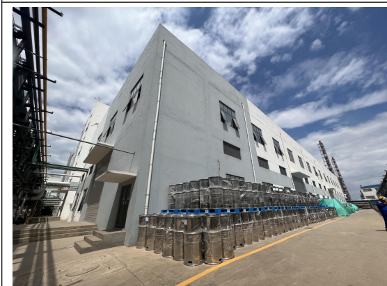
洗桶及仓库区厂房
