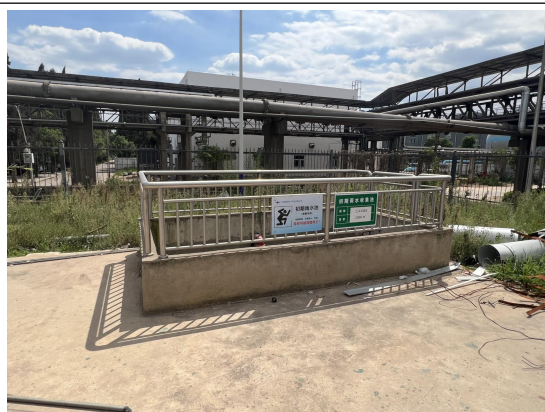
项目厂区初期雨水收集池
