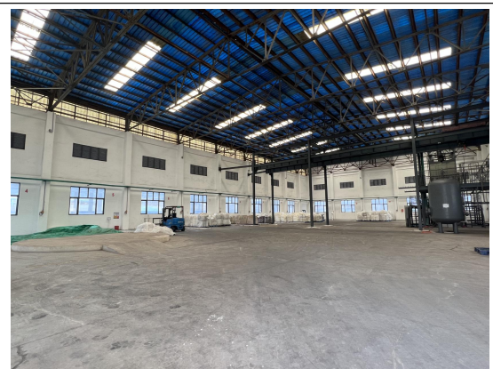
五氯化磷仓库（内部）
