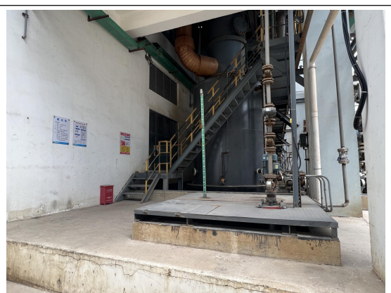
制气合成工段废水收集池
