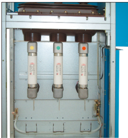
环网柜侧面的电缆室
