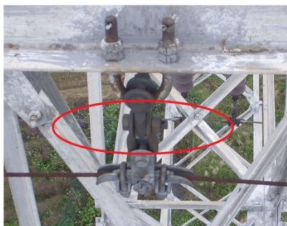
右地线悬垂线夹最上端螺母的开口销缺失
