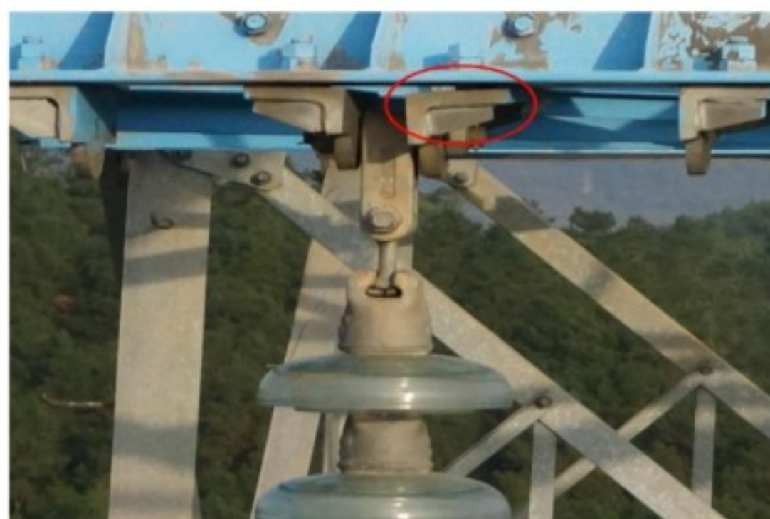
悬垂挂线点直角挂板有间隙
