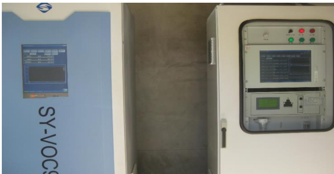
图 3.3-14 尾气在线监测系统（VOC/CEMS）
