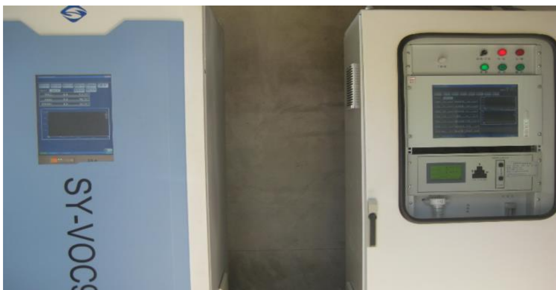
图 3.8-5 尾气在线监测系统（VOC/CEMS）
